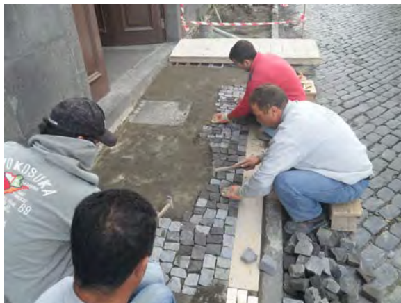
Figura 6.1: Calceteiros executando um pavimento.
