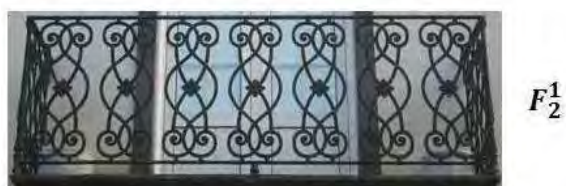
Figura 4.39: Varanda sita na Rua Dr. Aristides da Mota.
