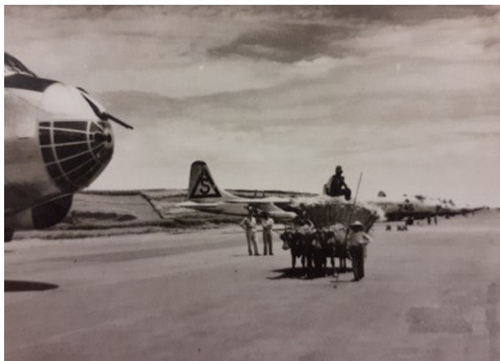
Figura 8 - Carreiros terceirenses a trabalhar nas obras do aeródromo das Lajes, anos 30.
