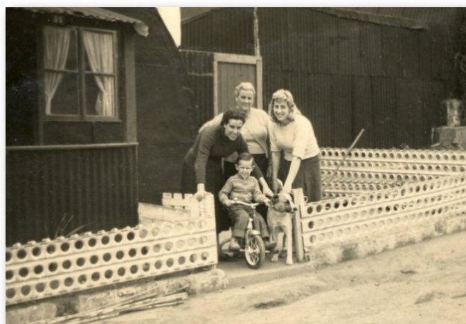
Figura 12 - Utilização das chapas metálicas da pista para muro de moradia, anos 50.
