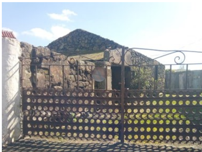
Figura 13 – Utilização das chapas metálicas da pista para portão de moradia, 2020.
