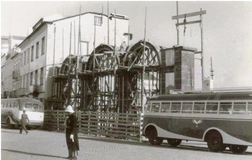
Fig. 39 – Desmontagem das portas da cidade para reconstrução no novo local previsto 1954
