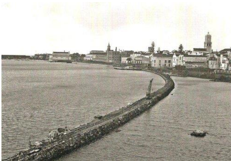
Fig. 34 – Início da construção da Avenida. 1948
