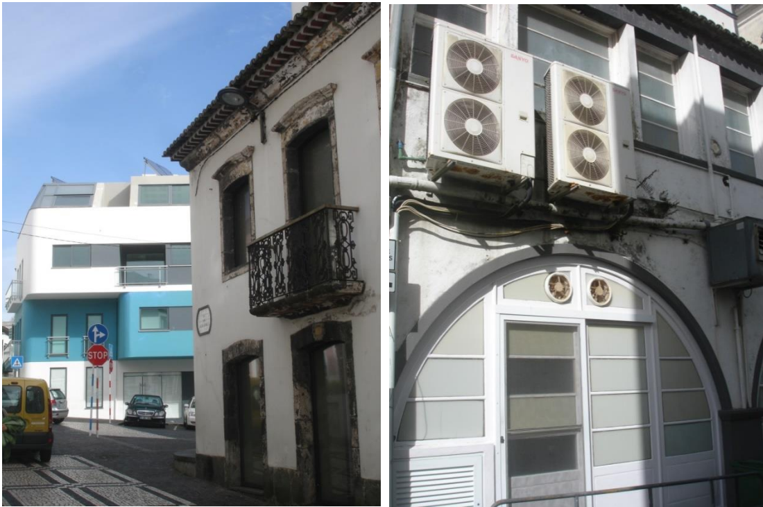
Fig. 68 e 69 – Rua dos Mercadores e Arco do antigo Cais da Alfândega
