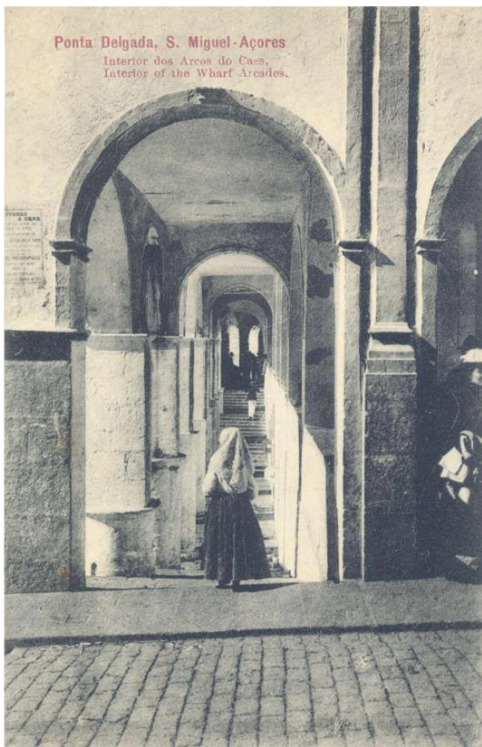
Fig. 12 – Interior dos Arcos do Cais da Alfândega
