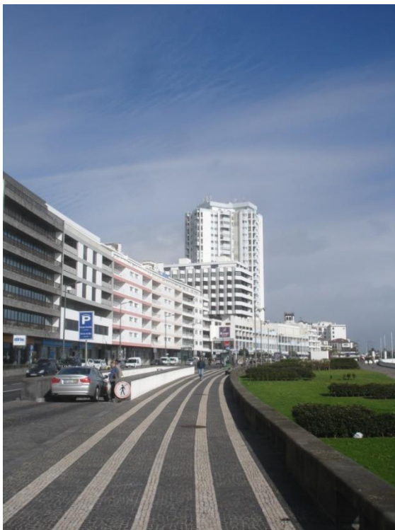
Fig. 71 – Edifício da marginal. 2014
