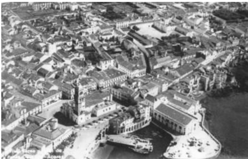
Fig. 13 - Vista aérea da cidade, já com a “Varanda de Pilatos” construída.
