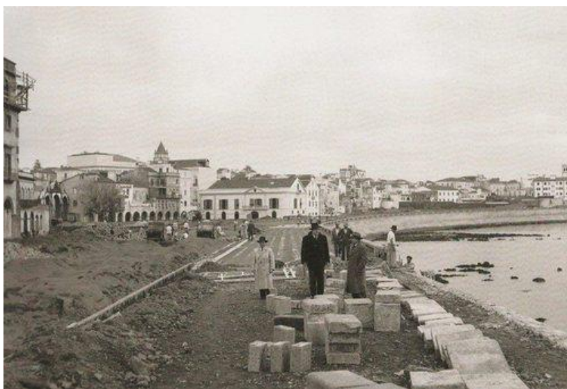
Fig. 35 – Foto da construção da Avenida Marginal do final dos anos 40.
