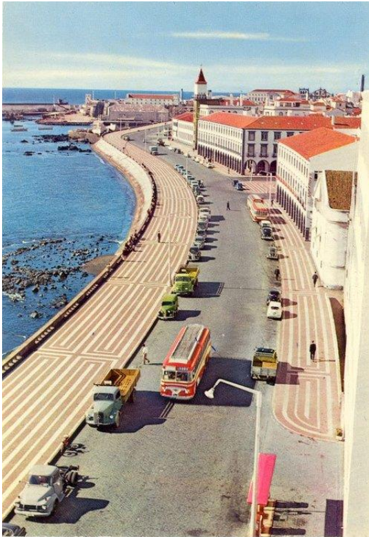
Fig. 47 – Vista parcial da Avenida Marginal onde ainda é visível parte das fundações do antigo cais da Alfândega. Início dos anos 60.
