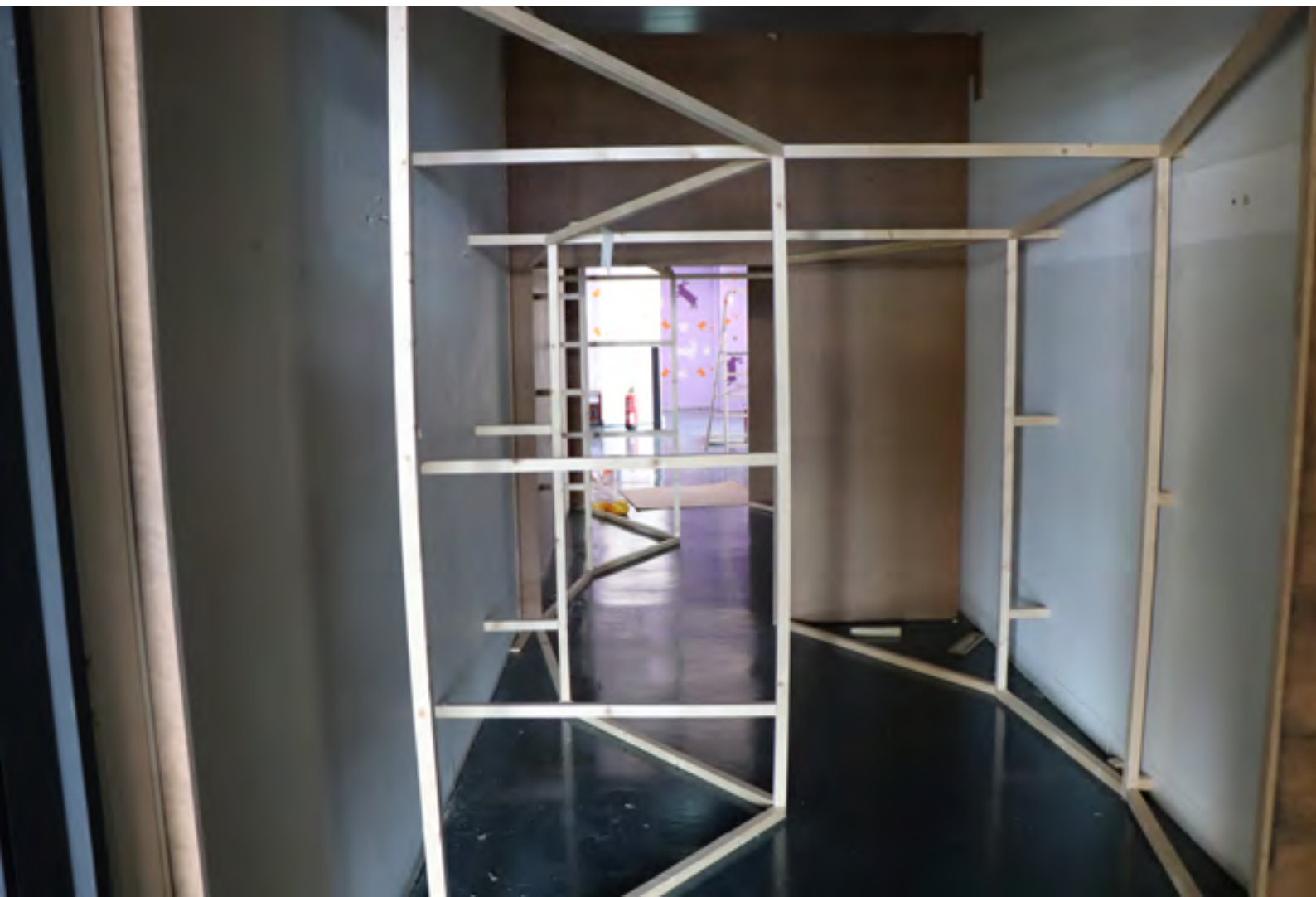
MONTAGEM DO TÚNEL © FOTOGRAFIA MANUEL MOREIRA
