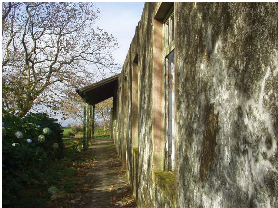
Ruínas da estação de TSF inglesa no Pico do Vigário. Foto actual. Frontaria.
