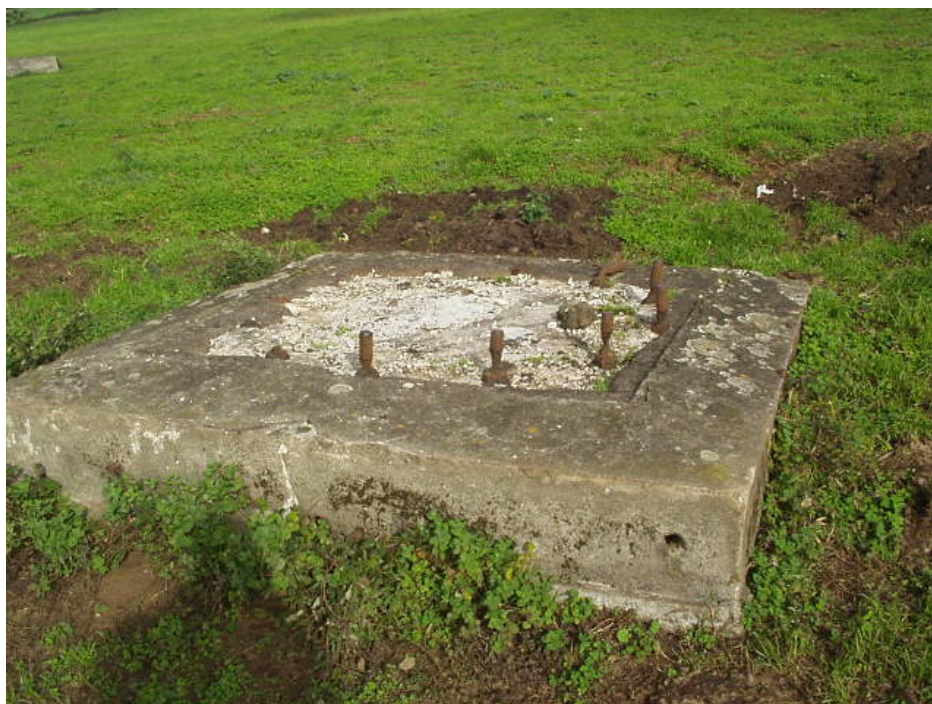
Base de uma das antenas da estação de TSF inglesa no Pico do Vigário. Foto actual.
