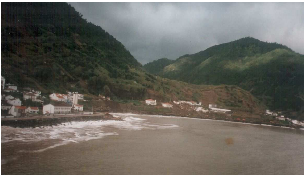
Fig. 24 - Cicatrizes de movimentos de massa de vertente ocorridos na noite de 31 de Outubro de 1997 na encosta da Freguesia da Ribeira Quente (Fotografia de P. Borges).
