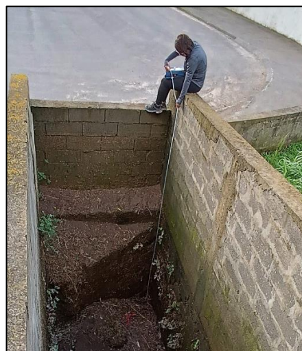
Figura 3.3 | Medição de concentração de gases no interior do poço localizado na plataforma lávica dos Mosteiros (ilha de S. Miguel, Açores).
