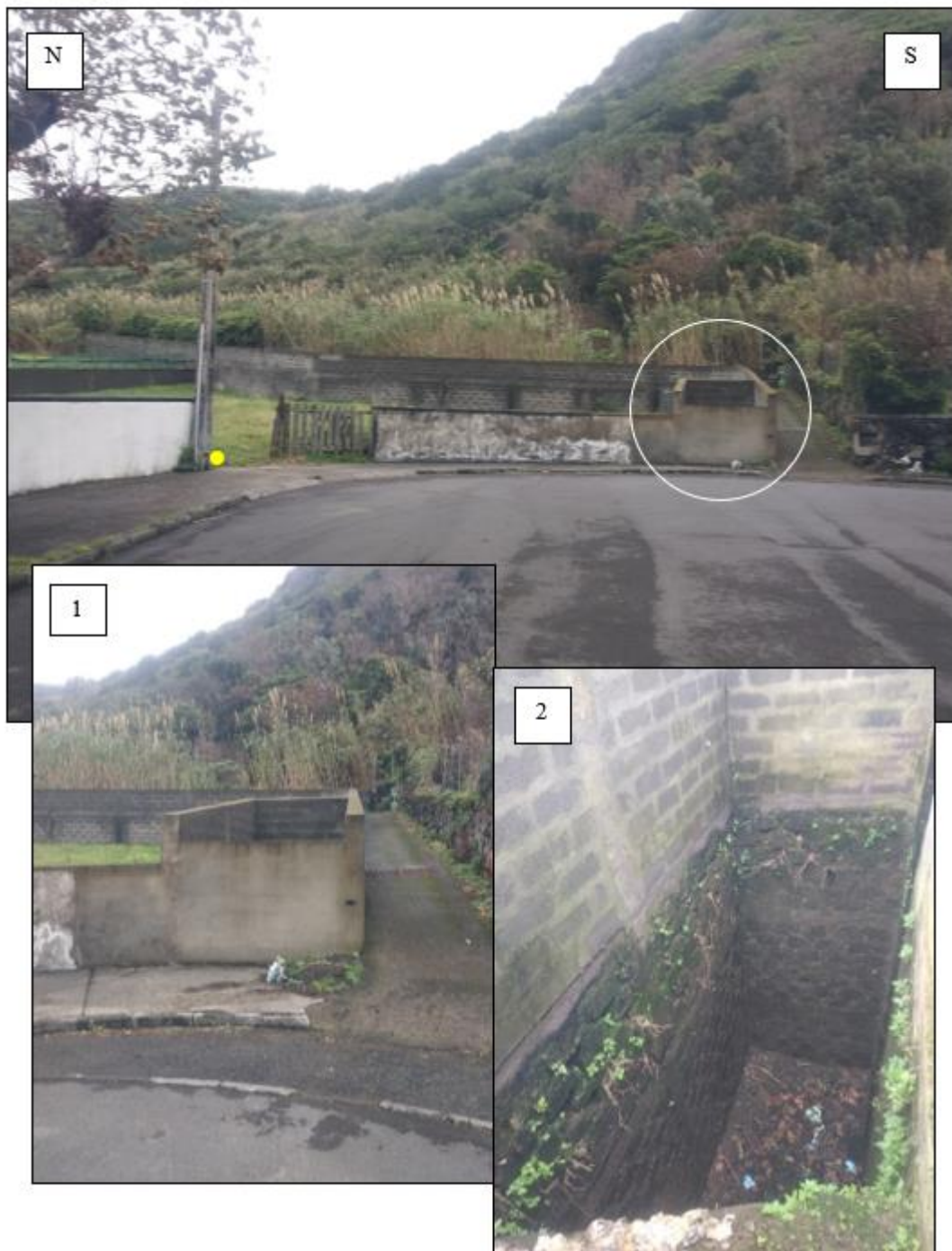
Figura 3.6 | Poço antigo, nos Mosteiros, onde terá ocorrido uma morte por inalação de \text{CO}_2 . O círculo a amarelo indica a localização do ponto de controle e a circunferência a branco o poço referido. As fotografias 1 e 2 apresentam uma aproximação ao poço e o interior do mesmo, respetivamente. Fotografias de 15/11/2023.
