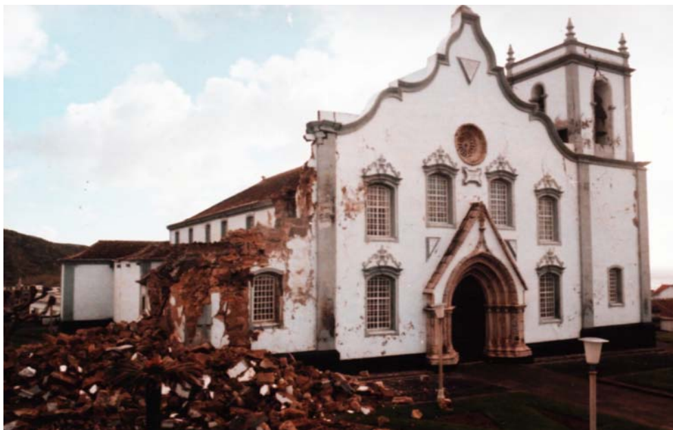
Fotografia I.1 – Efeitos do sismo de 1 de Janeiro de 1980 na Igreja Matriz da Praia da Vitória, ilha Terceira (Fotografia gentilmente cedida por Foto Íris).
