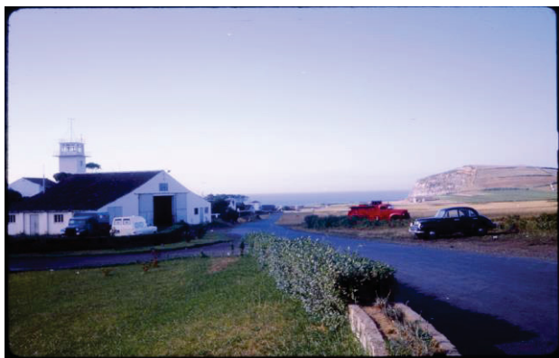
Figura 48: Fotografia em que se avista a torre de controlo do aeródromo de Santana e os edifícios à volta. Fonte: BPARPD, Coleção Manuel Silveira Paiva, cx.152, n.º 50
