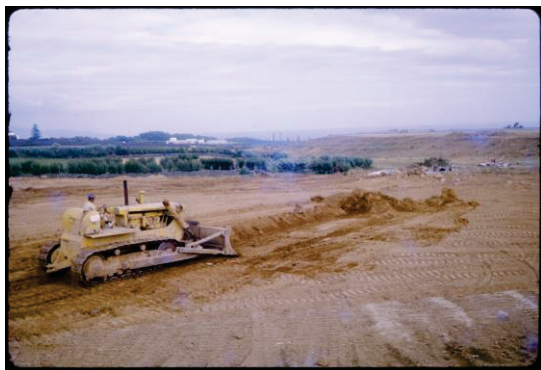
Figura 42: Trabalhos de terraplanagem no aeroporto da Nordela. Fonte: BPARPD, Coleção Manuel Silveira Paiva, cx.152, n.º 43
