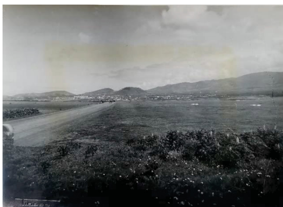
Figura 10: Reparação de pavimentos de macadame, Estrada Nacional 1-1ª em Santana - Rabo de Peixe, junto ao aeroporto
