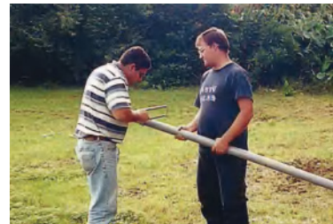
Figura 3 - Instalação de um piezómetro na margem da Lagoa das Sete Cidades
