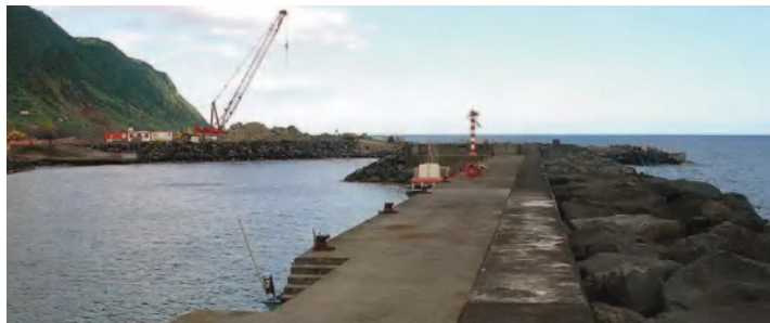
Figura 1 - Obras no novo Porto da Povoação, na Ilha de São Miguel.
