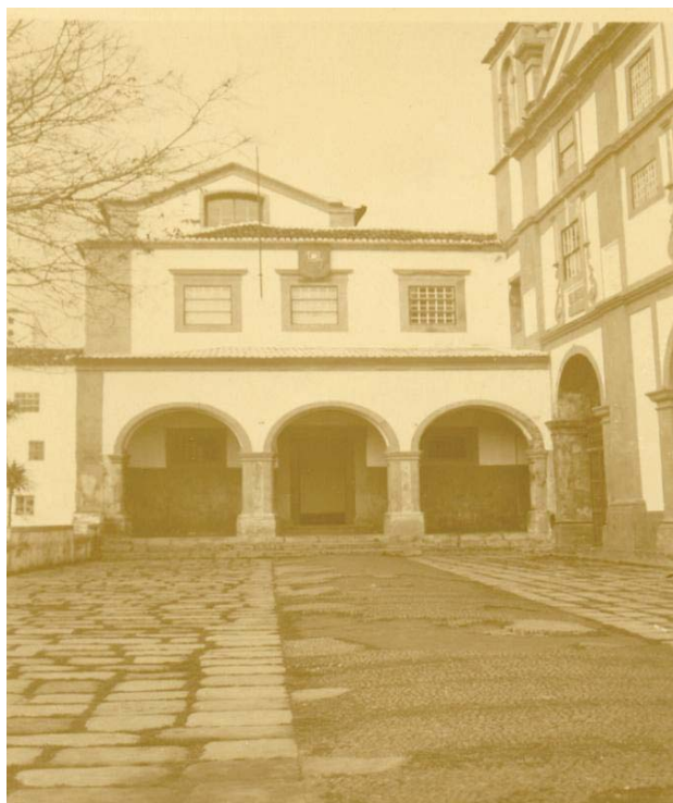
Fig. 7. Fachada do edifício do convento de S. Francisco nos anos 30 quando ali funcionava o Liceu Nacional de Angra e que virá a ser, a partir de 1970, o MAH MAH. Espólio Baptista de Lima
