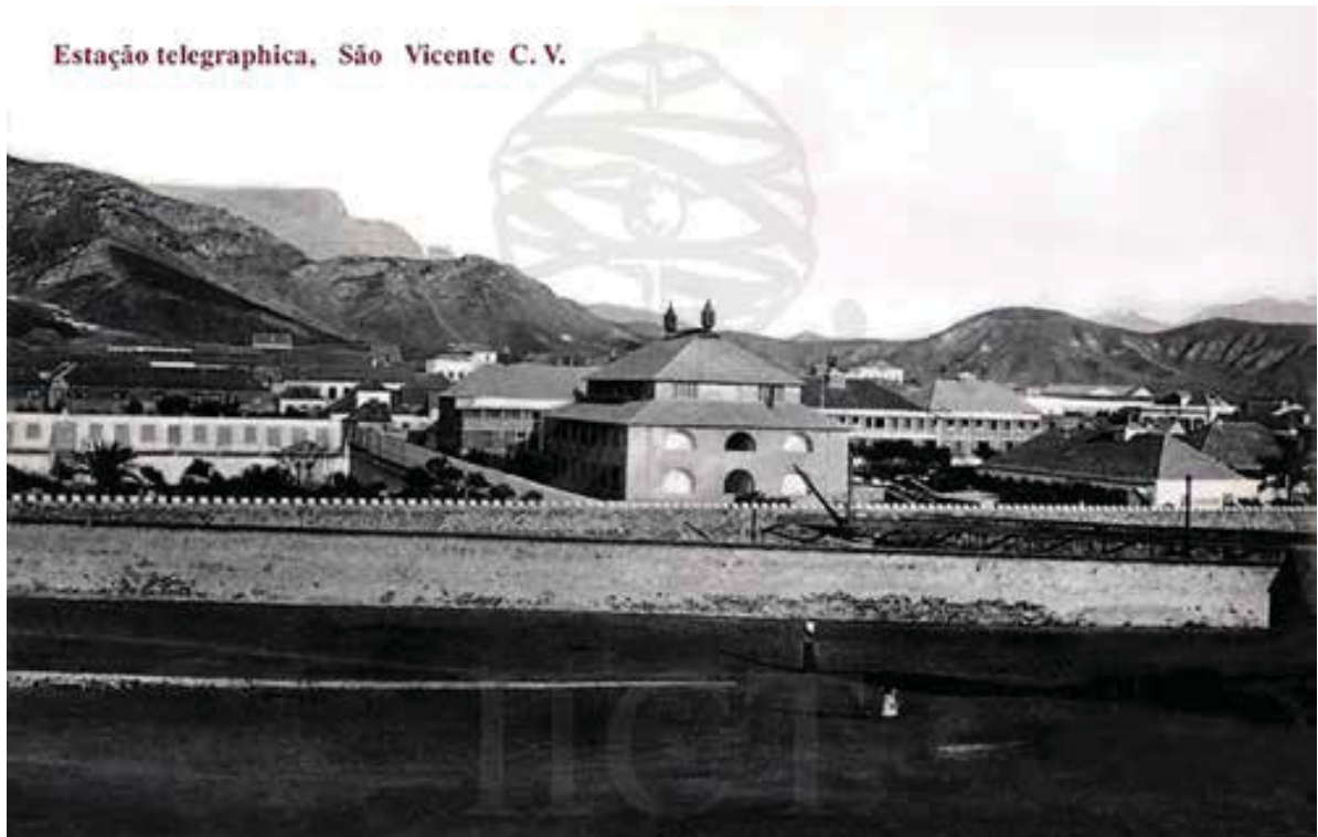
Fig. 2 – Estação Telegraphica, São Vicente (s.d.); Fonte: ACDT-IICT Arquivo Científico Tropical – Instituto de Investigação Científica Tropical.
