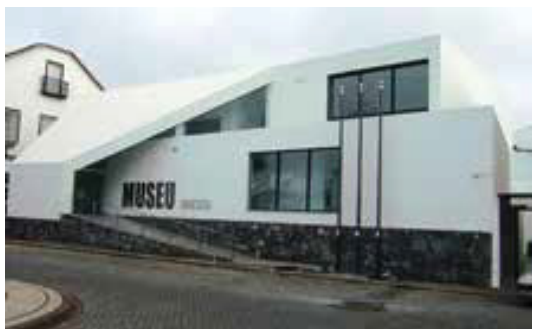
Fig. 6 - Fachada principal do novo Museu.
