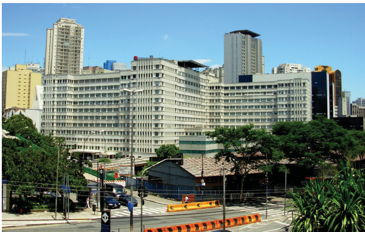
Figura n.º 5 Hospital Beneficência Portuguesa
