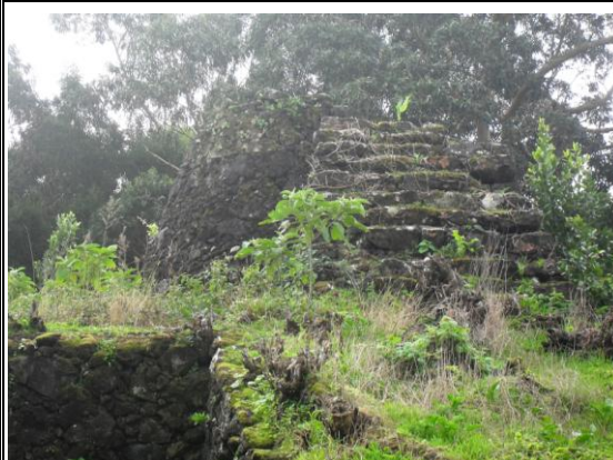
Figura 38: Escadas de acesso ao mirante
