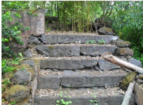
Figura 23: Escadas de acesso ao mirante
