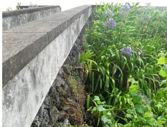
Figura 18: Escadas de acesso ao mirante
