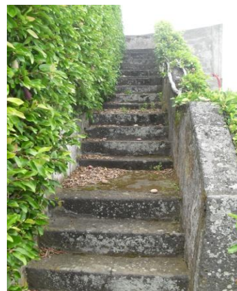
Figura 2: Escadas de acesso ao mirante
