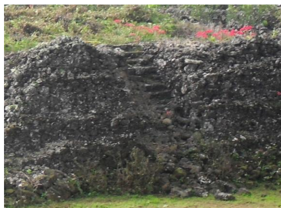
Figura 36: Escadas de acesso ao mirante
