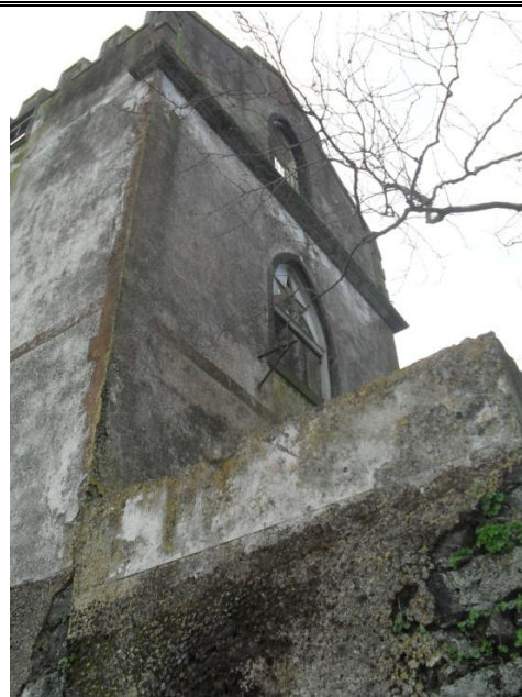
Figura 2: Torreão – Alçado posterior
