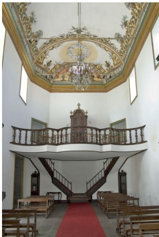
Figura 14 - Aspeto da parte posterior da nave antes da reabertura do antigo arco de ligação aos coros. (Foto: Hernâni Ponte)
