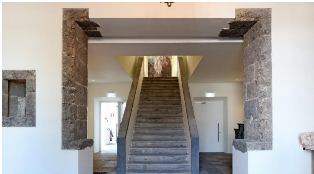
Figura 31 - Vão onde estariam localizadas as grades do locutório.
