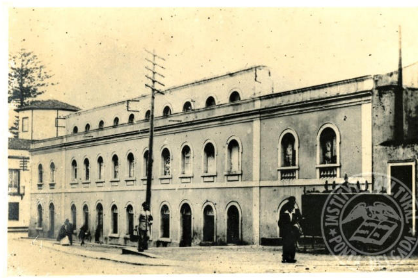
Figura 65 - Fachada nascente do Teatro Micaelense, onde é visível o corpo de remate à direita. Fonte: ICPD (PT/ICPD/CFD.00423)
