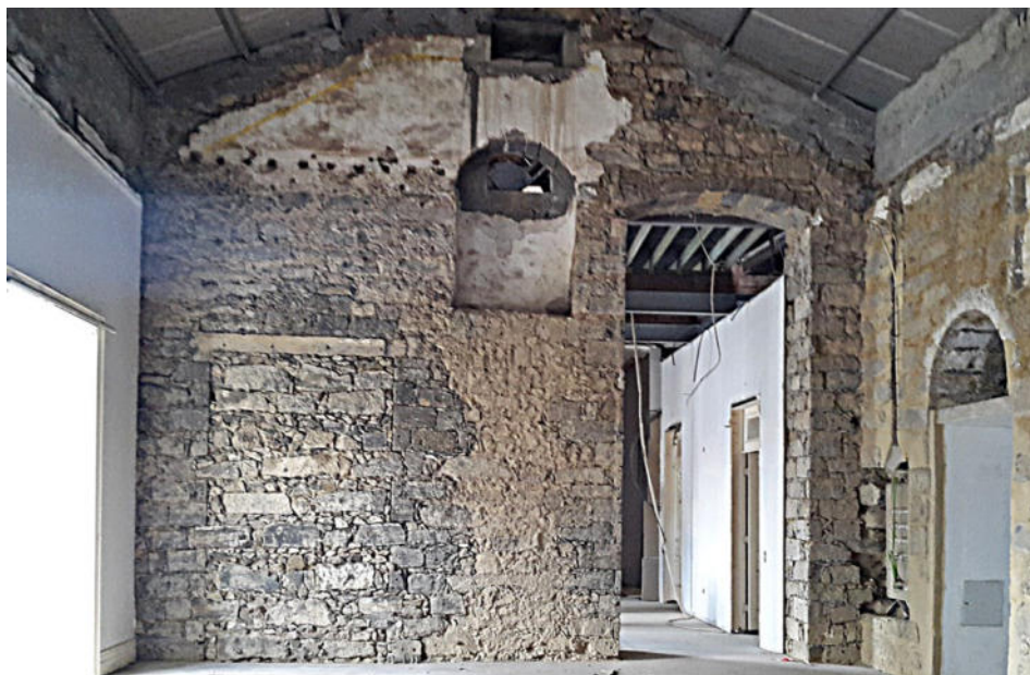
Figura 28 - Parede sul do coro alto com nicho superior e lintel na alvenaria durante a intervenção de 2019
