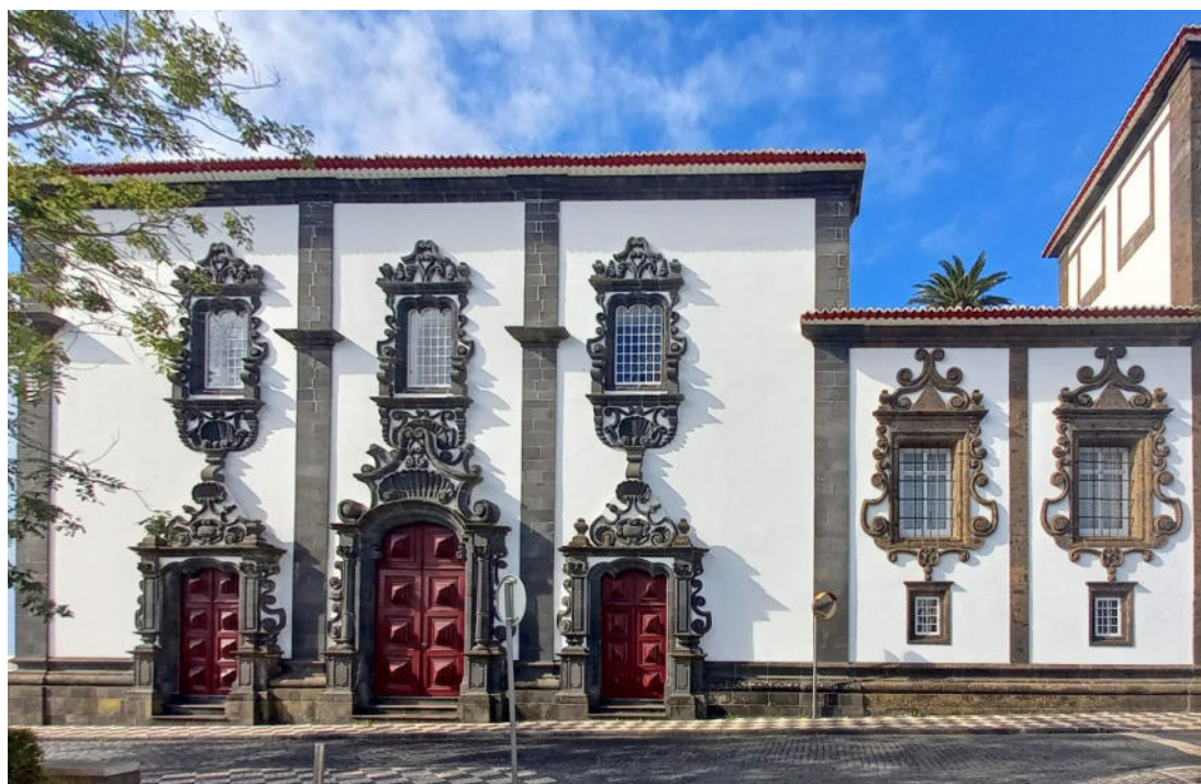
Figura 12 - Fachada da Igreja e capela-mor.
