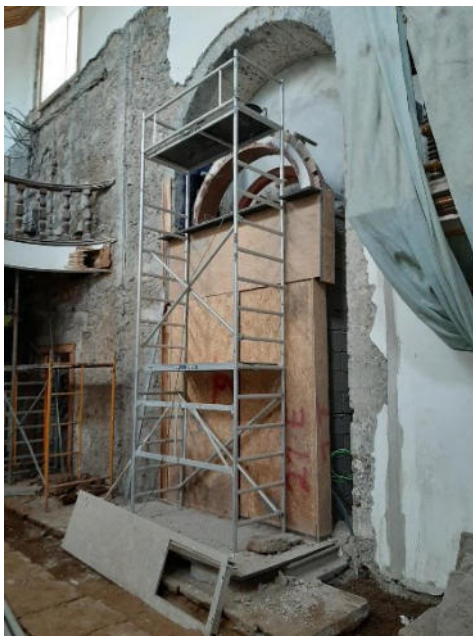
Figura 15 - Nicho do altar do lado do evangelho (de São Joaquim) durante a intervenção de restauro.
