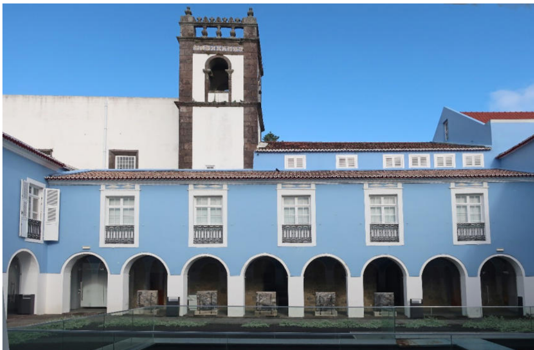
Figura 73 - Vãos do estilo micaelense na ala nascente do claustro.
