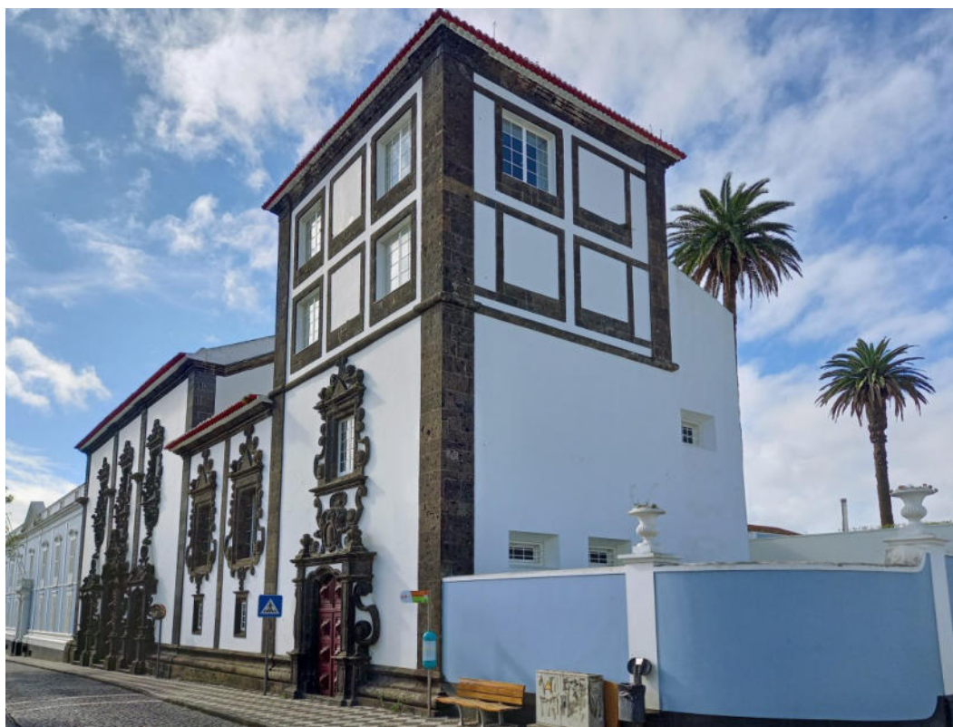
Figura 20 - Torreão mirante - vista do lado norte onde existiu edifício adossado.
