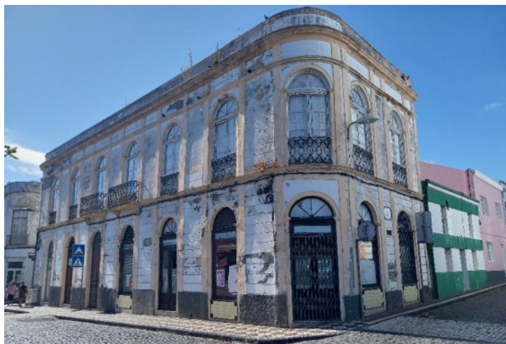
Figura 96 - Edifício construído para remate das expropriações da Rua Formosa
