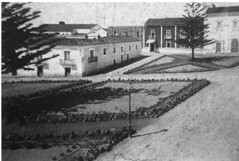
Figura 88 - Vista a partir do Largo da Conceição, após a demolição do corpo dos dormitórios, com a construção da ala sudeste já iniciada (ca.1895) Fonte: Autor desconhecido, reproduzida em Afonso, 2007.
