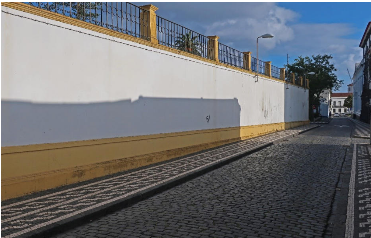
Figura 79 – Muro poente do Palácio Fonte Bela.
