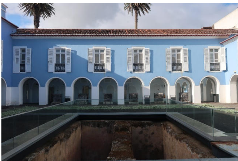
Figura 23 - Ala a norte do claustro com escavações da cisterna em primeiro plano.
