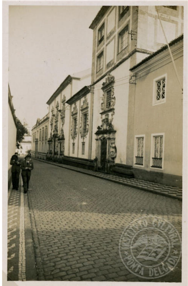
Anexo 26 - Vista da fachada nascente com o corpo da secretaria militar em primeiro plano. PT/ICPD/CFD.00393
