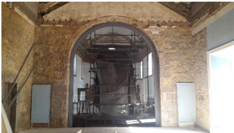
Figura 30 - Parede norte do coro alto com o arco de separação com a igreja
