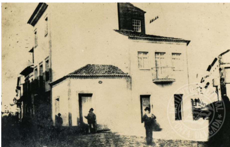
Figura 68 – Início da demolição de edifícios para construção do troço da Rua Formosa (atual Largo 2 de março) entre a Rua de São Miguel e a Rua da Canada– 1897-1898 Fonte: ICPD - PT/ICPD/CFD.01632
