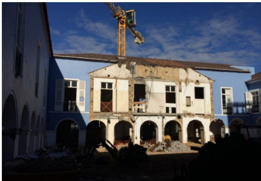
Figura 22 - Demolições de corpo adossado no lado poente do claustro durante a intervenção de 2015 - Fonte: pluggo
