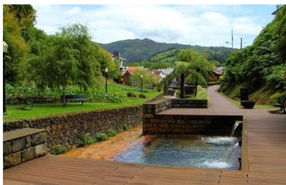
Fig. 3.56. Poça da Dona Beija após as obras de ampliação
