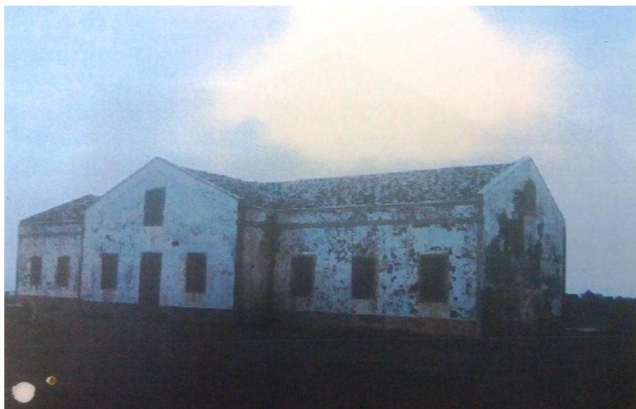
Figura 3.106. Aspeto do estabelecimento termal em estado de abandono, em 2005
