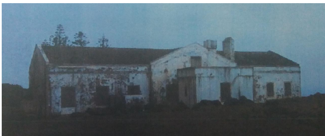
Figura 3.107. Aspeto do estabelecimento termal em estado de abandono, em 2005
