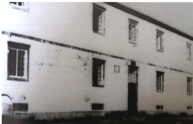
Fig. 3.20. Hospital da Filantropia
