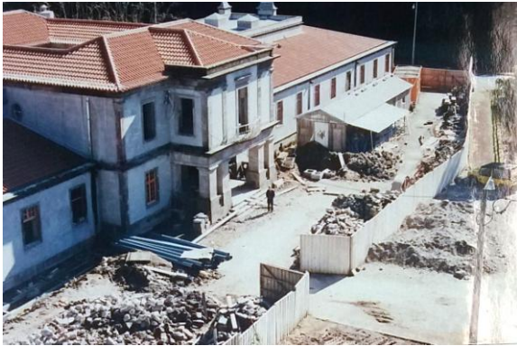
Fig. 3.47. Fachada do edifício termal durante a 1ª fase de obras
