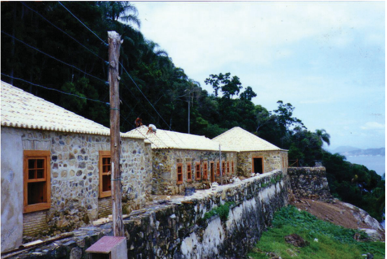
11 - Vista dos Quartéis durante as obras de restauração da Fortaleza de Ratonés. Fonte: Acervo do DAEX/UFSC - Date: 1990. Disponível em: http://fortalezas.org/index.php?ct=fortaleza&id_fortaleza=2
