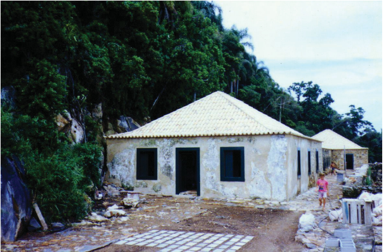
10 - Fortaleza de Ratoes durante as obras de restauração ocorridas em 1990. Fonte: Acervo do DAEX/UFSC - Date: 1990. Disponível em: http://fortalezas.org/index.php?ct=fortaleza&id_fortaleza=2
