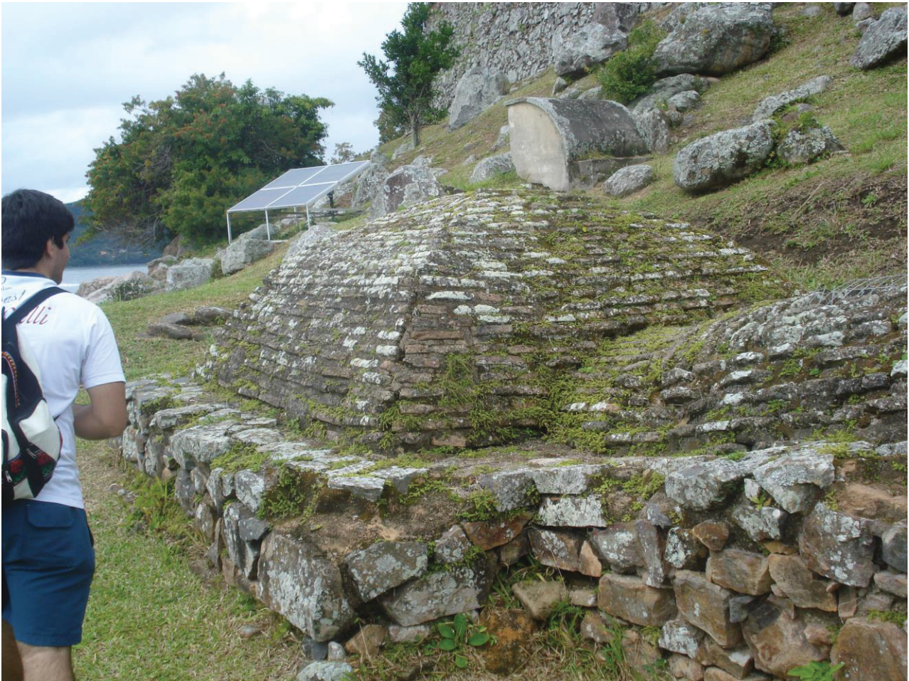
19 - Fonte de Água que se encontra no início da Rampa de Acesso da Fortaleza de Rationes. Logo atrás é possível ver as placas fotovoltaicas que abastece a Ilha de Rationes e a Fortaleza de energia cem por cento ecológica. A Fortaleza de Rationes é a única entre as fortalezas de Santa Cruz de Anhatomirim e Ponta Grossa que possui este tipo energia. Fonte: Acervo pessoal de Jefte.
