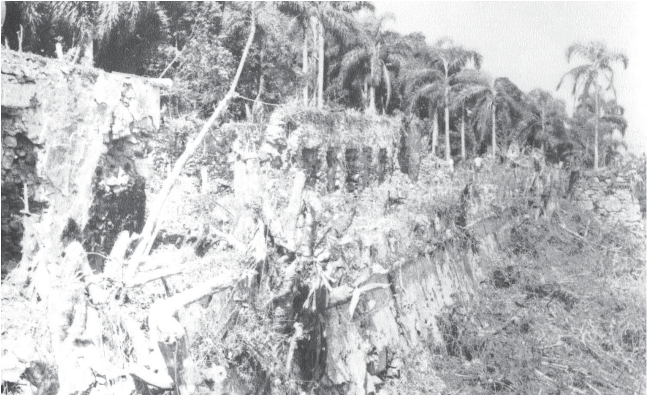
4 - Na foto acima, datada de 1962, vemos a vista do que é a casa do comandante e o quartel da tropa completamente danificados pela ação do tempo, sem janelas, tetos, portas, etc. Ao fundo ficava a cozinha e na frente desta uma guarita, que foram demolidas pela ação do tempo. Na frente dos edifícios é possível ver o parapeito das muralhas caídas e a vegetação por toda a fortaleza de Ratoe. Diferente do que estamos acostumados a ler na historiografia oficial catarinense, as fortalezas não foram completamente abandonadas após a invasão espanhola em 1777, mas durante a geração contemporânea. Fonte: Waldir Fausto Gil. Acervo de Walter F. Piazza - Date: 1962. Site: fortalezas.org
