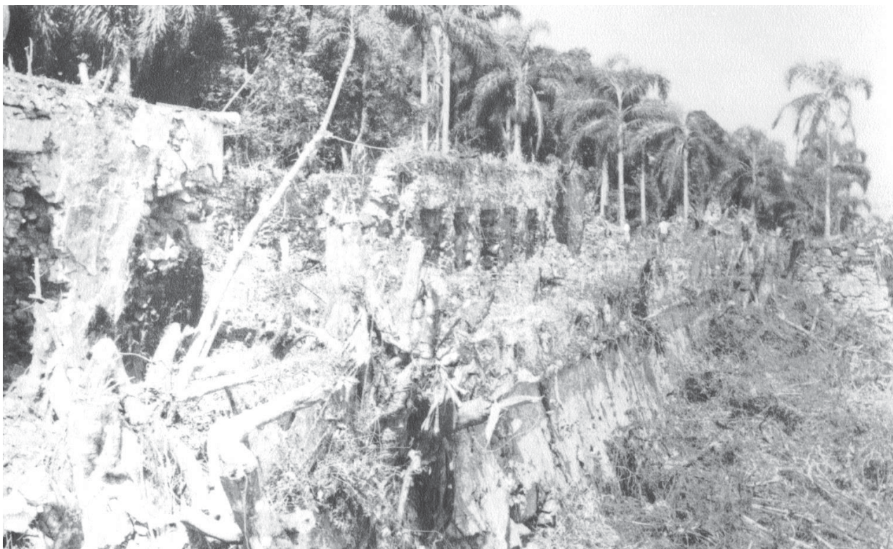
7 - Fortaleza de Ratonés durante os serviços de limpeza realizados em 1962. Observamos o Quartel da Tropa, Cozinha e parte da Muralha completamente tomado pela vegetação. Fonte: Waldir Fausto Gil. Acervo de Walter F. Piazza - Date: 1962. Disponível em: http://fortalezas.org/index.php?ct=fortaleza&id_fortaleza=2
