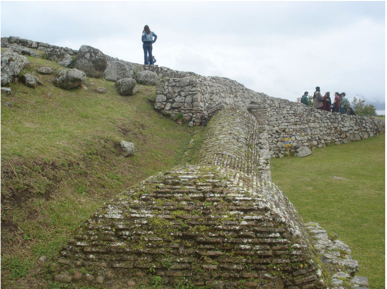
20 - A Fonte de Água, junto com a Fortaleza de Ratoles, é uma das maravilhas arquitetônicas deixadas pelos portugueses que ainda resiste de pé. Fonte: Acervo pessoal de Jefte.
