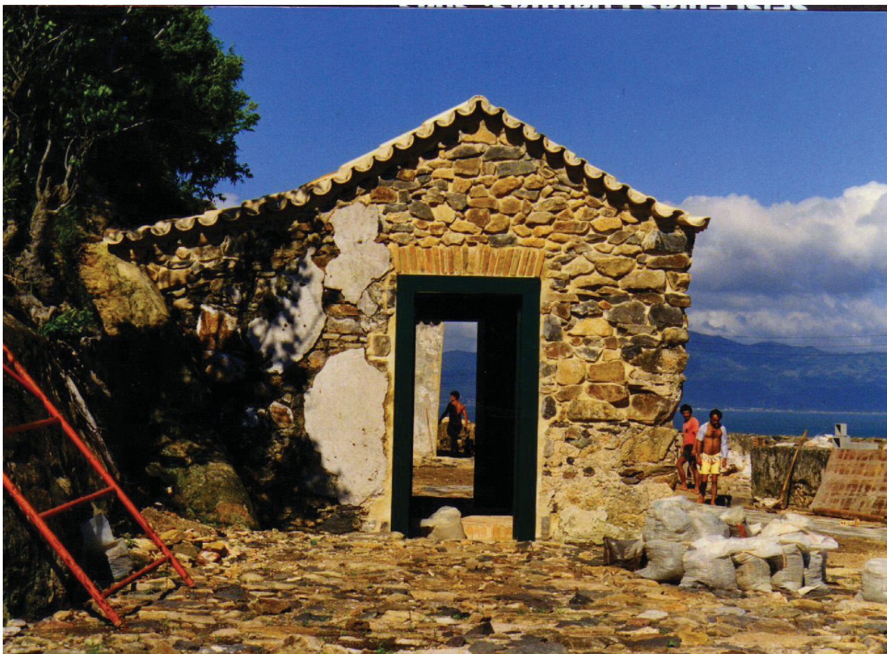
6 - Obras de restauração da Casa da Palamenta da Fortaleza de Ratonés, ocorridas em 1990. Fonte: Acervo do DAEX/UFSC - Date: 1990. Disponível em: http://fortalezas.org/index.php?ct=fortaleza&id_fortaleza=2 Acessado em: 28/11/2016.
