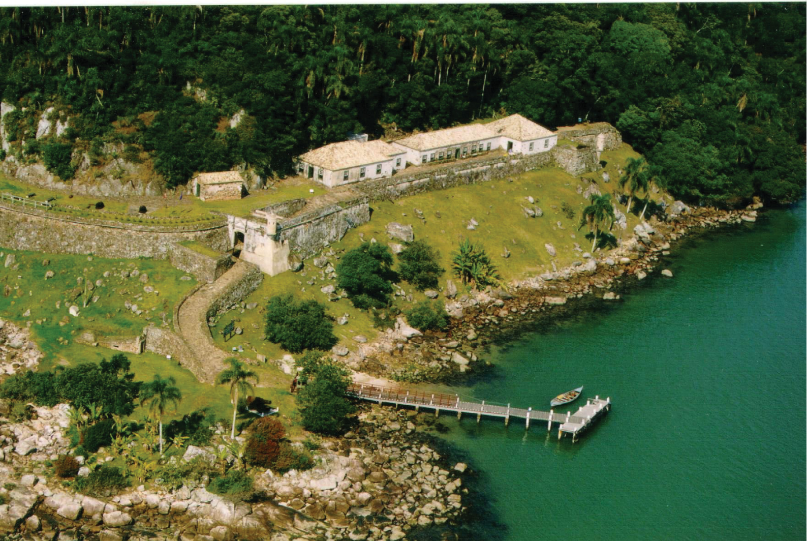
2 - Na imagem acima, podemos ver um panorama geral da Fortaleza de Santo Antônio de Ratonés. A única peça “atual” que não corresponde ao período da construção da Fortaleza de Ratonés, é o canhão Whitworth, de alma sextavada, que na foto está sob a sombra da palmeira, perto da entrada do trapiche. Foto: Alberto L. Barckert, Acervo do Projeto Fortalezas Multimídia/UFSC - Date: 1999. Site: fortalezas.org
