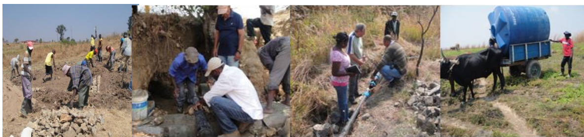
Figura 10 - Instalação dos sistemas de abastecimento de água por gravidade.
