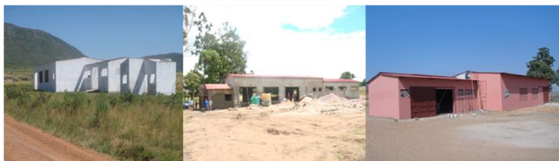
Figura 15 - Construção de armazéns de apoio à comercialização.
