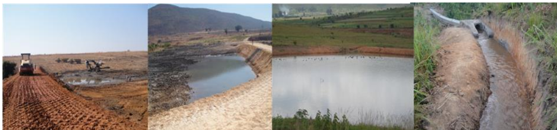
Figura 12 - Construção de infraestruturas de apoio à irrigação.
