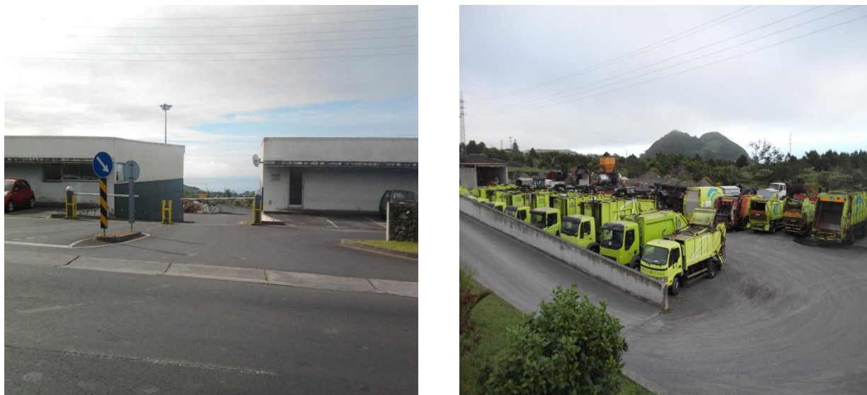
Figura 4. Estaleiro e parque de viaturas da Câmara Municipal de Ponta Delgada (Fotografias do Autor)
