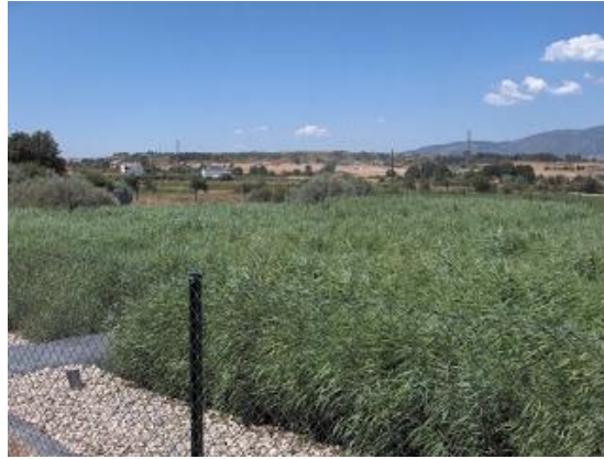
Figura 16 – Zona Húmida Construída (Fonte: Botequilha, 2013).
