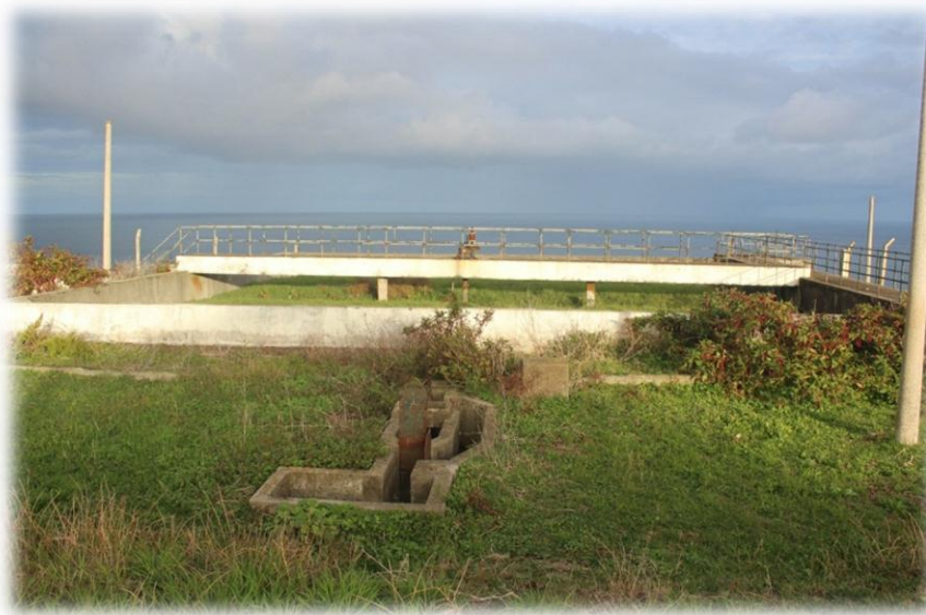
Figura 28 - ETAR da Vila de São Sebastião (Fonte: Própria).
