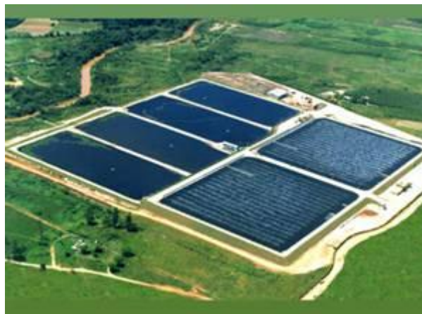
Figura 15 – Lagoas de estabilização (Fonte: Garcia, [s.d.]).
