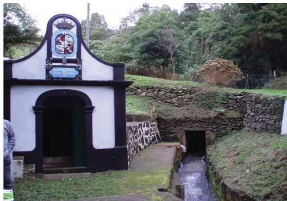
Figura 22 - Entrada da nascente da Nasce – Água – NAG. Foto.: José Machado
