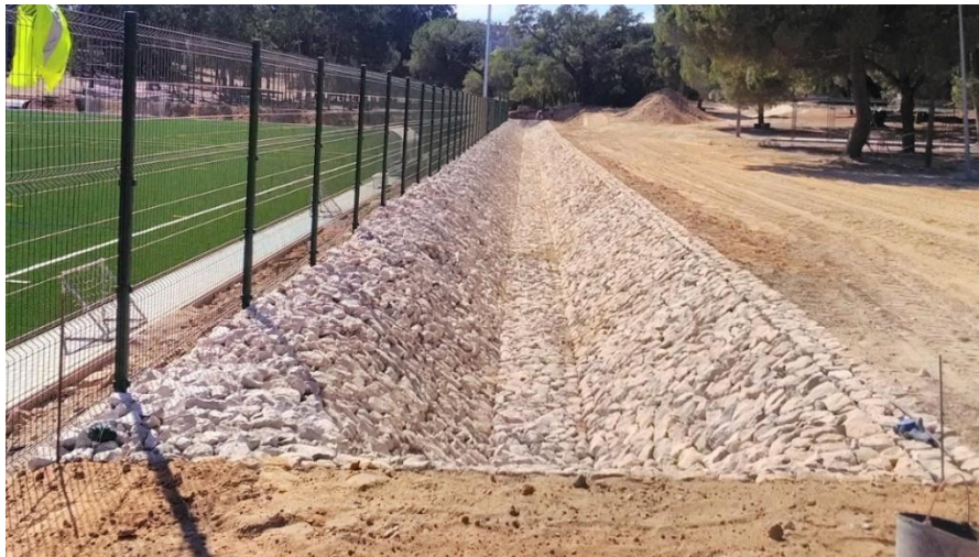
Figura 6.8 Exemplo de vala drenante no Seixal, implementada pela Câmara Municipal.
