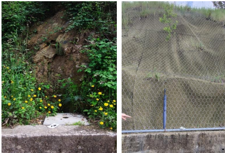
Figura 6.13 Talude com a presença de uma rede de retenção em Fraião.
