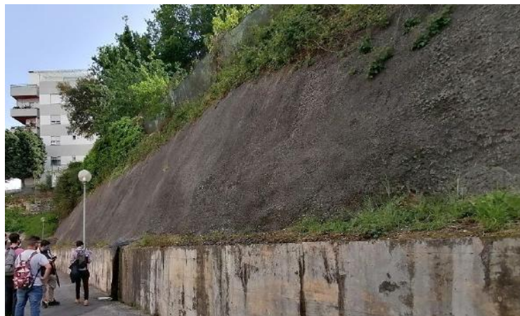
Figura 6.14 Talude de estabilizado com betão projetado.
