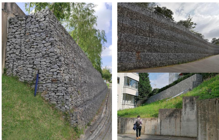
Figura 6.12 Muros de retenção em Fraião.
