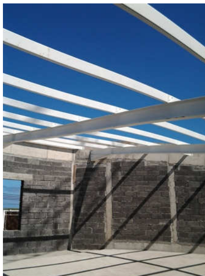
Figura 13 – Estrutura metálica de cobertura.
