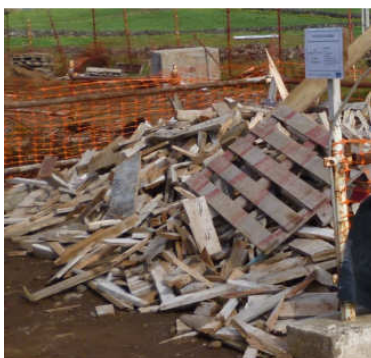
Figura 18 – Baia para armazenamento de madeira.
