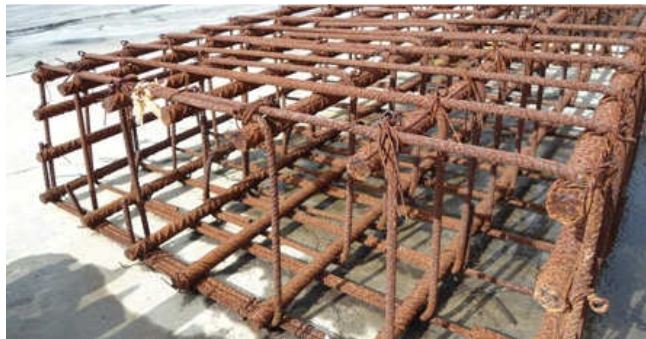
Figura 12 – Armadura pré-fabricada.
