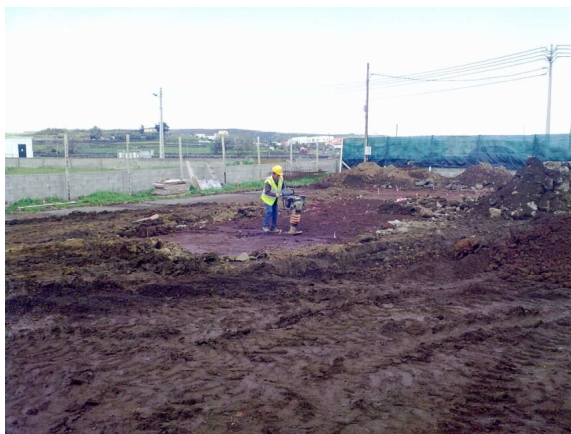
Figura 20 – Aterros em obra e compactação.
