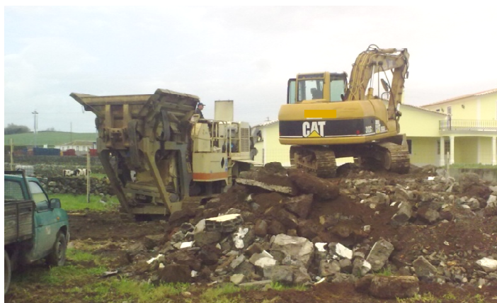
Figura 19 – Britagem de inertes em obra.
