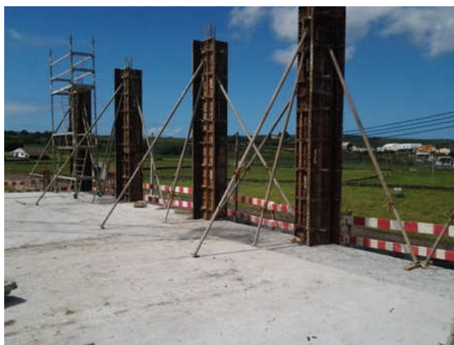
Figura 10 – Cofragem metálica (pilares).
