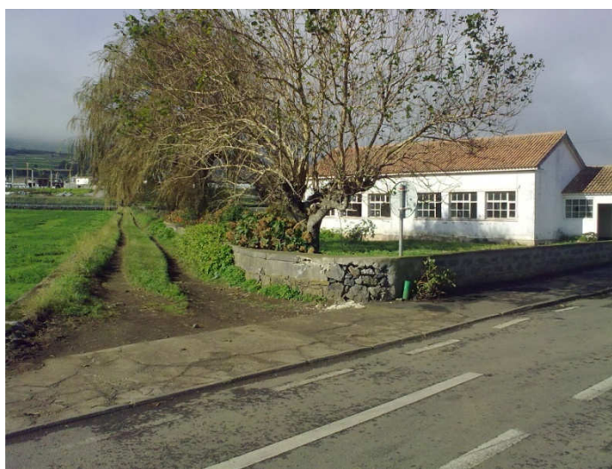
Figura 9 – Edifício a demolir
