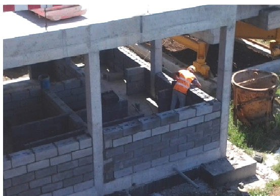
Figura 14 – Execução de alvenarias.
