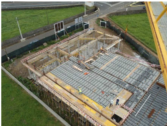
Figura 11 – Cofragem tradicional de madeira (lajes).
