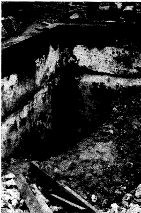
Foto 6 — Visão parcial da cisterna (Estrutura C) a que se sobrepôs o tanque de jardim (Estrutura B)
