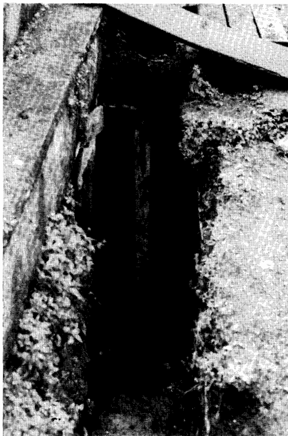
Foto 3 — Escadaria (Estrutura A)
