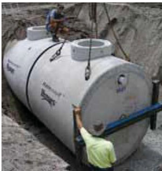
Figura 36: Tanque em betão enterrado (Department of Water, 2011)
