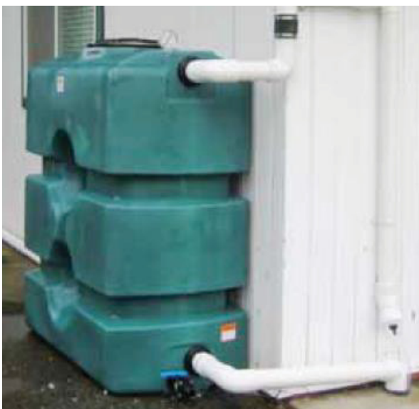
Figura 37: Tanque em PEAD implementado acima do solo (SAIT Polytechnic, 2013)
