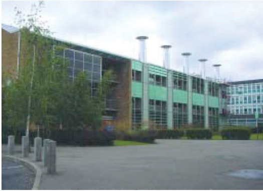
Figura 2: Sede do Building Research Establishment , certificada pelo BREEAM, Garston, Reino Unido (Pinheiro, 2006)
