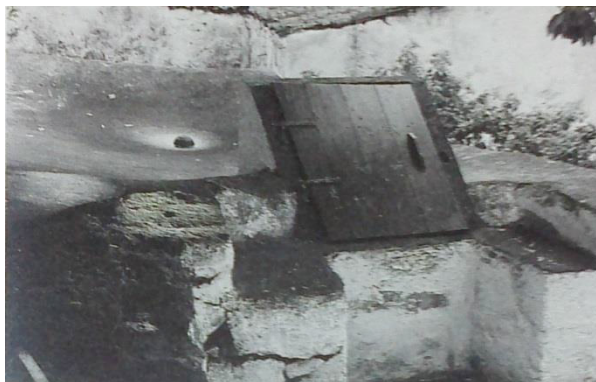
Figura 26: Cisterna, Rosais, São Jorge (Caldas, 2000)
