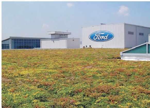
Figura 42: Cobertura extensiva implementada num edifício da Ford, Michigan, Estados Unidos da América (USEPA, 2008)
