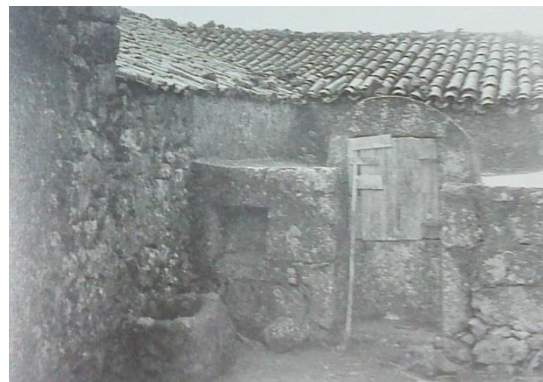
Figura 27: Cisterna, Santo Amaro, São Jorge (Caldas, 2000)
