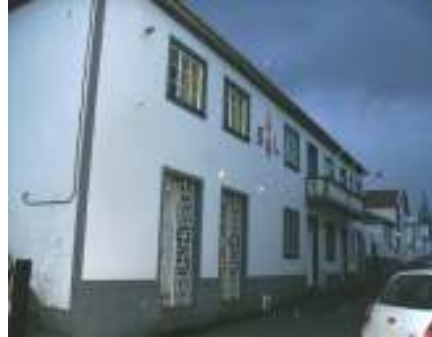
Filarmónica Progresso Lajense
