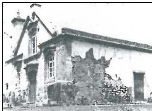
Foto 2.1 – Igreja das Quatro Ribeiras, após o sismo de 1 de janeiro de 1980 ( in Merelim, 1983).
