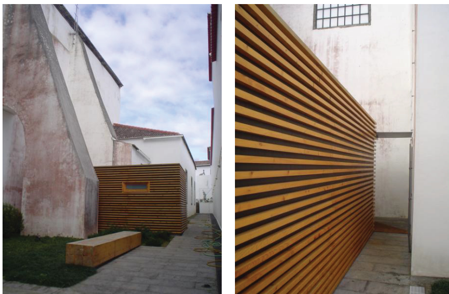
[137- 138] igreja do Colégio, aspectos do volume que abriga as instalações sanitárias.
