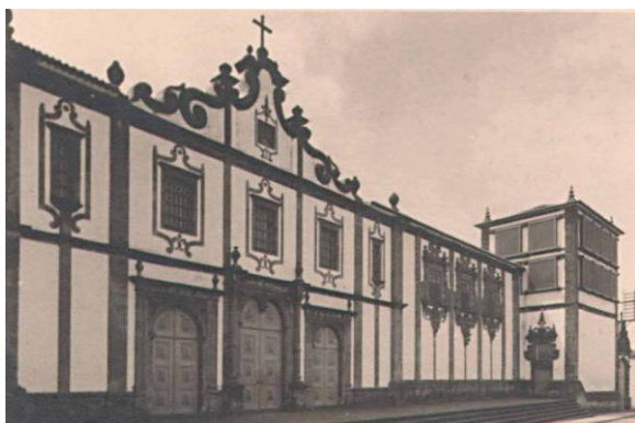
[73] Fachada da igreja e torreão poente.
