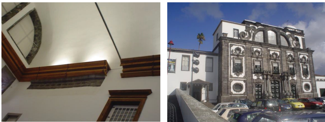
[134- 135] igreja do Colégio, sobreposição das duas arquitecturas, cornijas e fachada sul.
