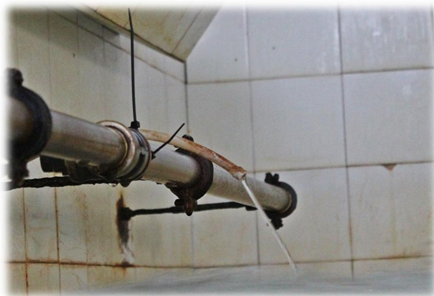
Figura 5.6. Injeção de hipoclorito de sódio nas águas que chegam à ETA do Pico Vermelho (fotografia captada a 25 de setembro de 2014).
