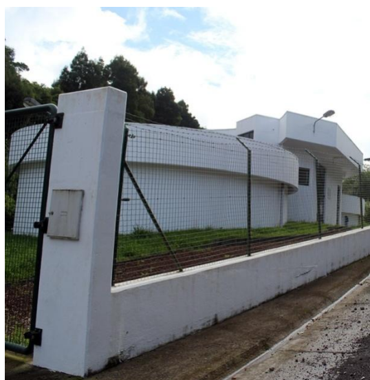
Figura 5.4. Reservatório de regularização - Cachaços (fotografia captada a 25 de setembro de 2014).
