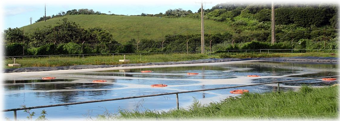
Figura 6.10. Estação de Pré-tratamento de Águas Lixiviantes (fotografia captada a 16 de setembro de 2014).
