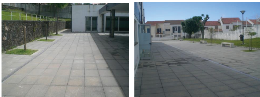
Figura 33 - Espaços de recreio exterior - Escola B
