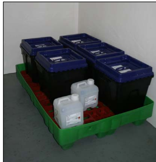
Figura 6 – Bacias de retenção e contentores de resíduos nas câmaras de armazenagem temporária.
