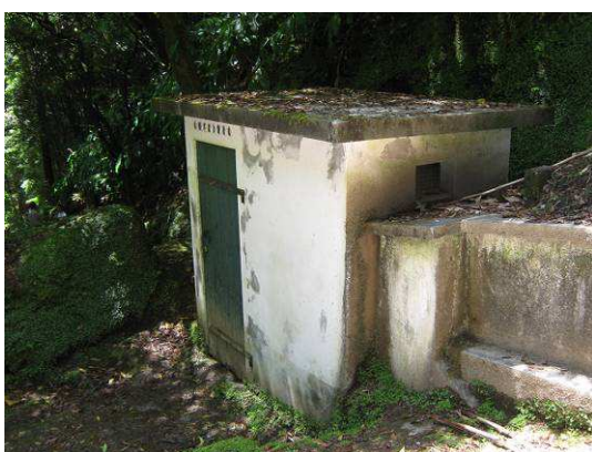
Figura A29 - Nascente da Ribeira dos Passarinhos
