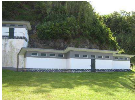
Figura A10 - Nascente da Chã dos Tanques
