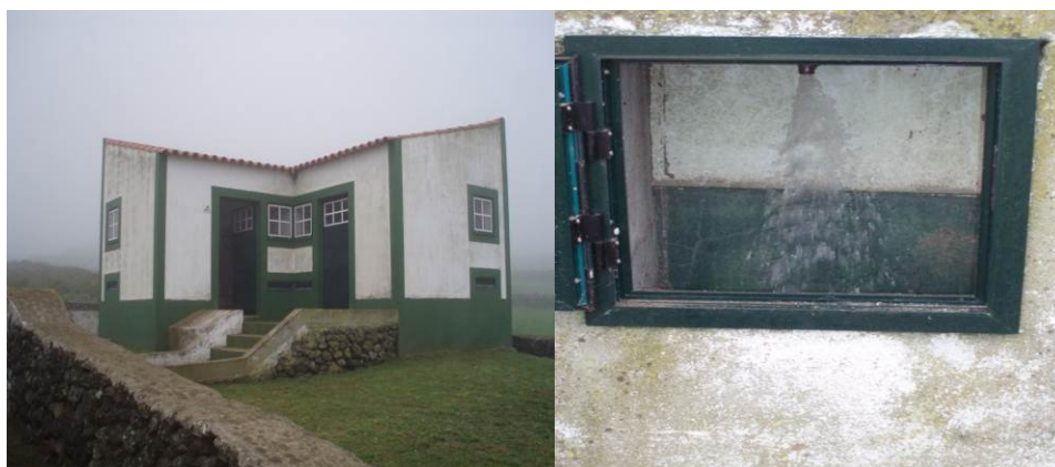
Figura 41 - Edifício e ponto de recolha no furo da Canada do Mato. Foto. :José Machado.
