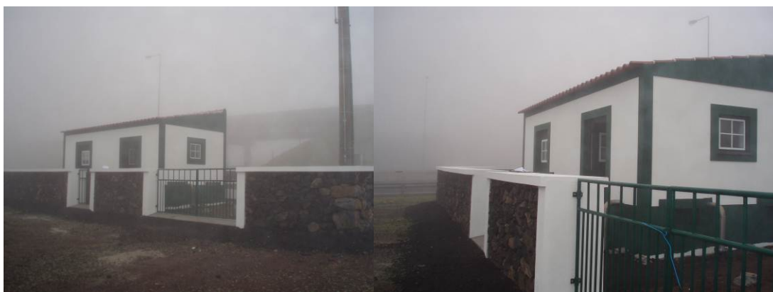
Figura 43 – Estrutura de captação do furo da Achada. Foto.:José Machado.
