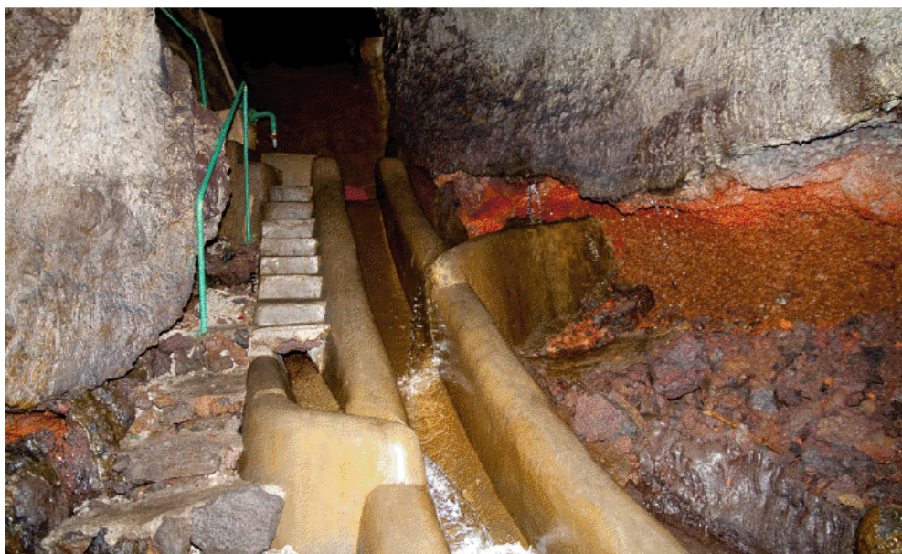
Figura 44 – Calha onde se processa o transporte da água da nascente da Furna de Água, Cabrito, ao longo do tubo lávico. Foto: SMAH.
