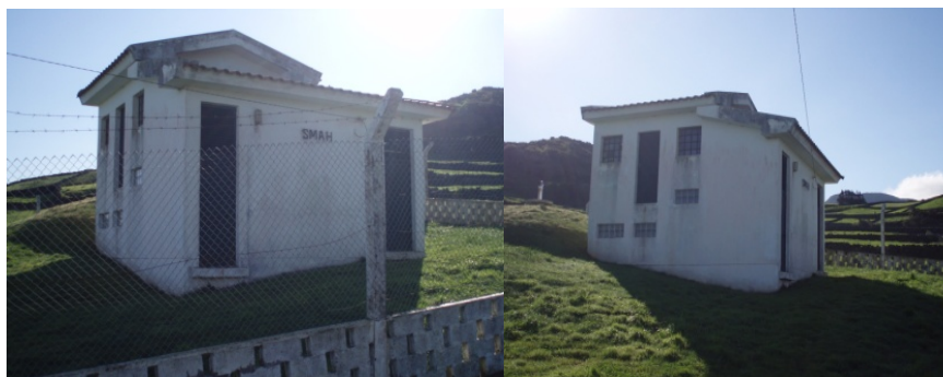
Figura 35 - Estrutura de captação das nascentes do Raminho – RAM. Foto.: José Machado.
