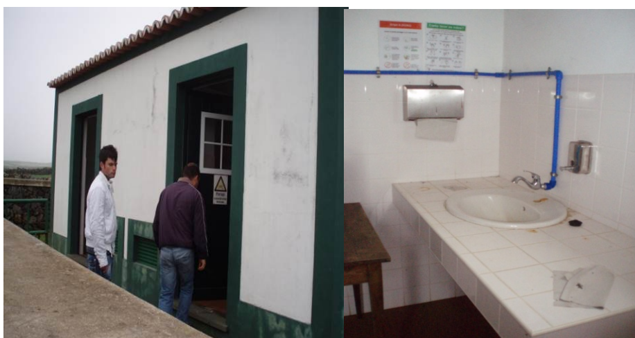
Figura 42 – Edifício e ponto de recolha do furo de Santana. Foto.: José Machado.
