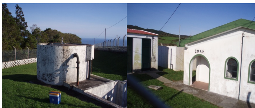
Figura 36 – Estrutura de captação das nascentes dos Altares – ALT. Foto.: José Machado.
