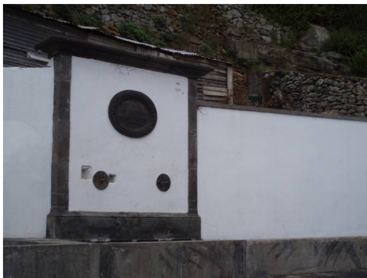
Figura 56 – Chafariz na nascente da fonte da Ribeirinha. Foto.: José Machado
