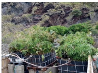
Figura 1 - Ensaio piloto de uma zona húmida construída para o tratamento de águas residuais
