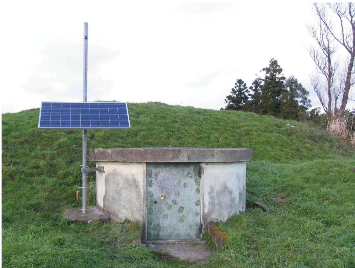
Figura 7.25 - Aspeto geral da cave sísmica da estação PPGR.
