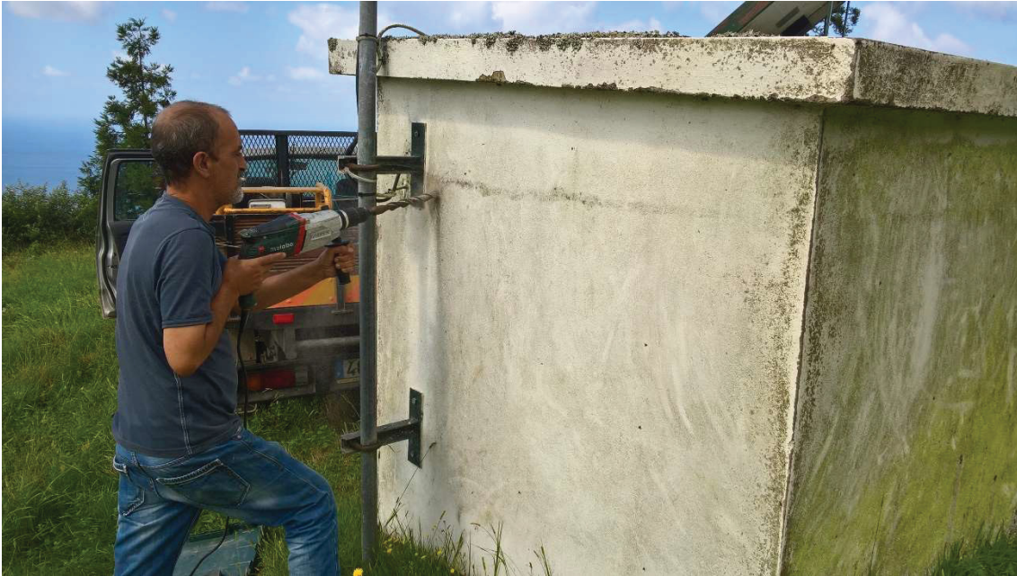
Figura 6.10 – Aumento da abertura pré-existente para passagem do cabo de GPS.
