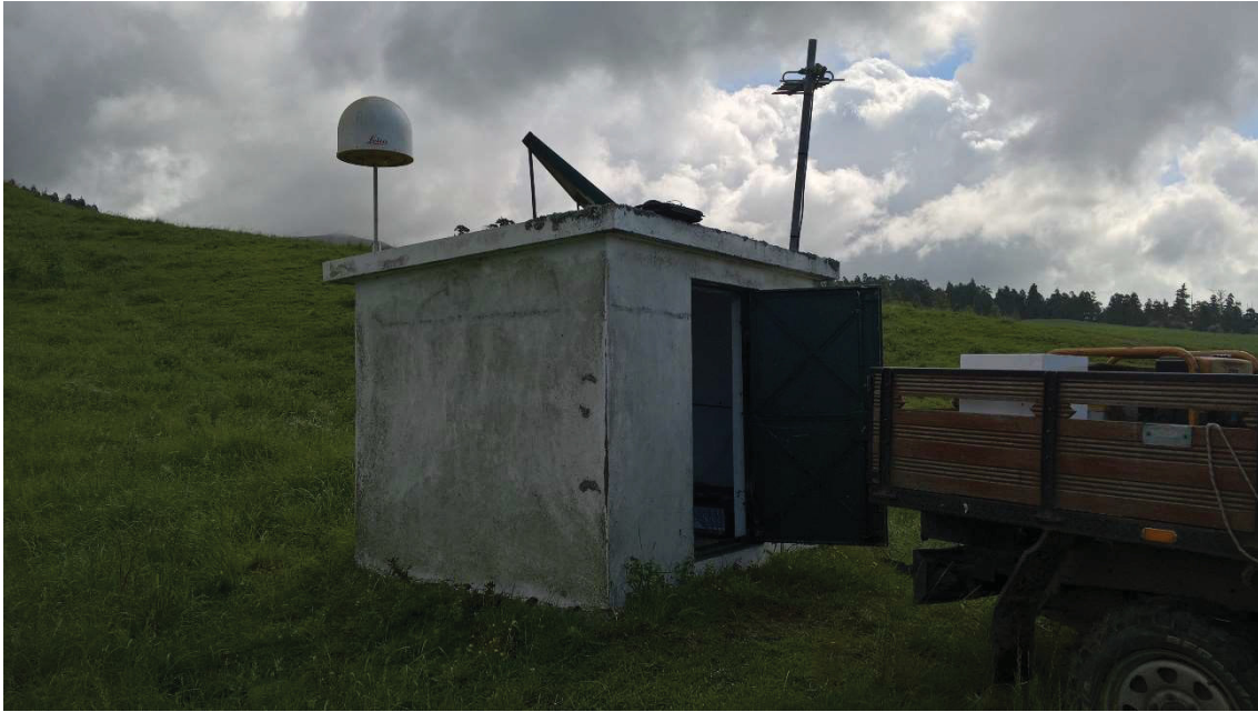
Figura 6.9 – Aspeto geral do abrigo da estação sísmica PFET.
