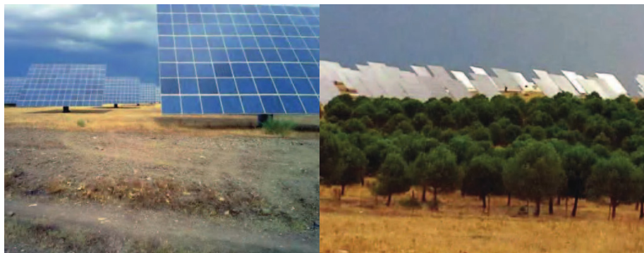
Fig. 1 – Central Solar Fotovoltaica da Amareleja (Alentejo – Portugal), agosto de 2017. Fonte - Autor
