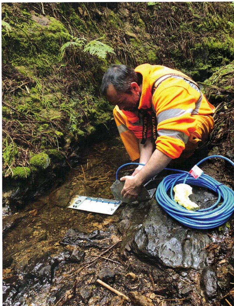
Instalação de um dos sensores do sistema de monitorização das dinâmicas hidrológicas de uma das nascentes de linhas de água localizadas no Planalto dos Graminhais.
