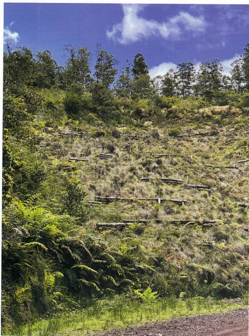
Derrocada restaurada na estrada da Tronqueira, Nordeste, através de técnicas de engenharia natural e plantação de espécies nativas.
