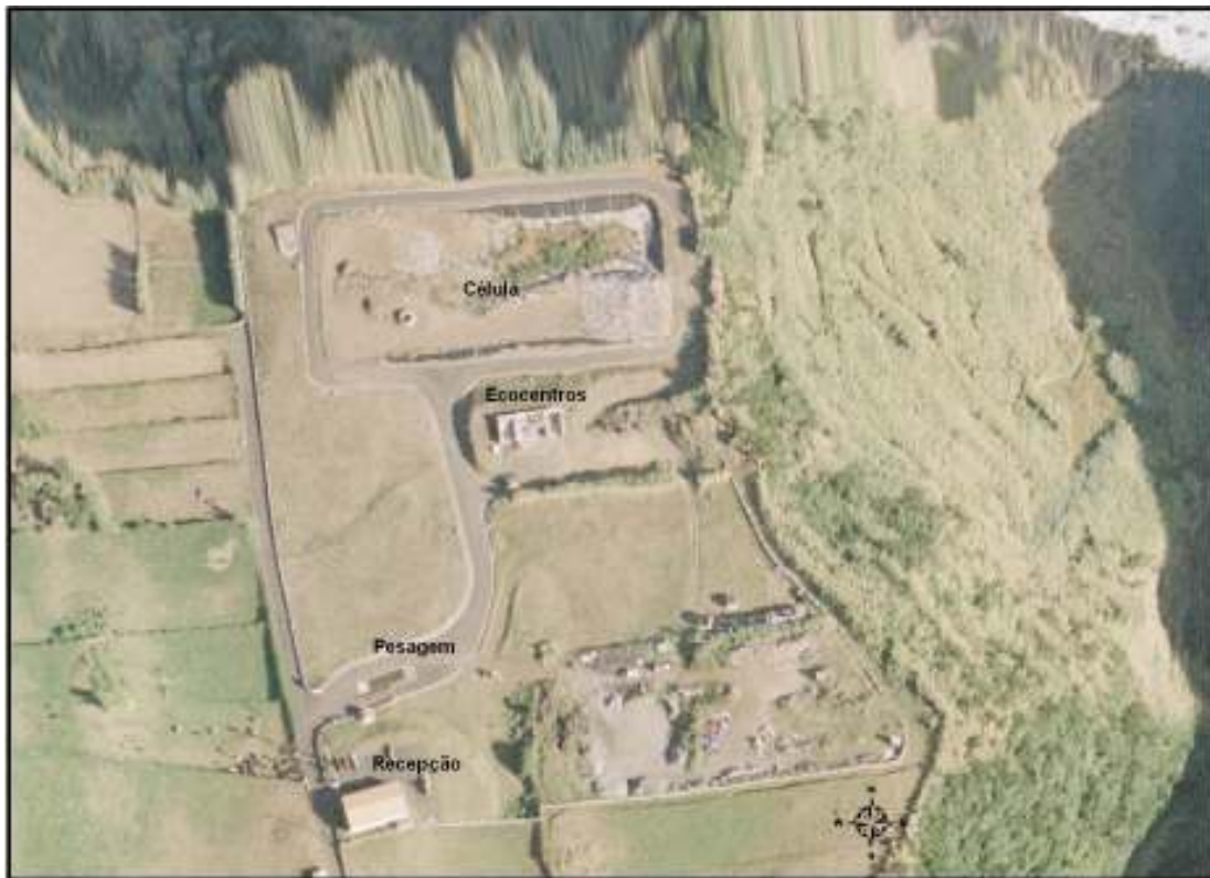
Figura 9: Vista aérea do aterro sanitário de Nordeste (Fonte: Nordeste Activo, E.M., 2010).
