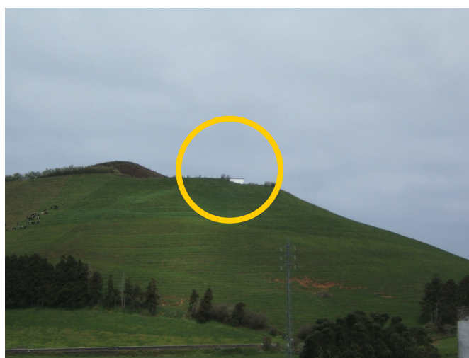
Figura 4.11 – Imagem do Reservatório Central dos SMAS
