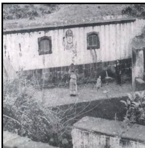
Gravura 18: Depósito de água das Bicas
