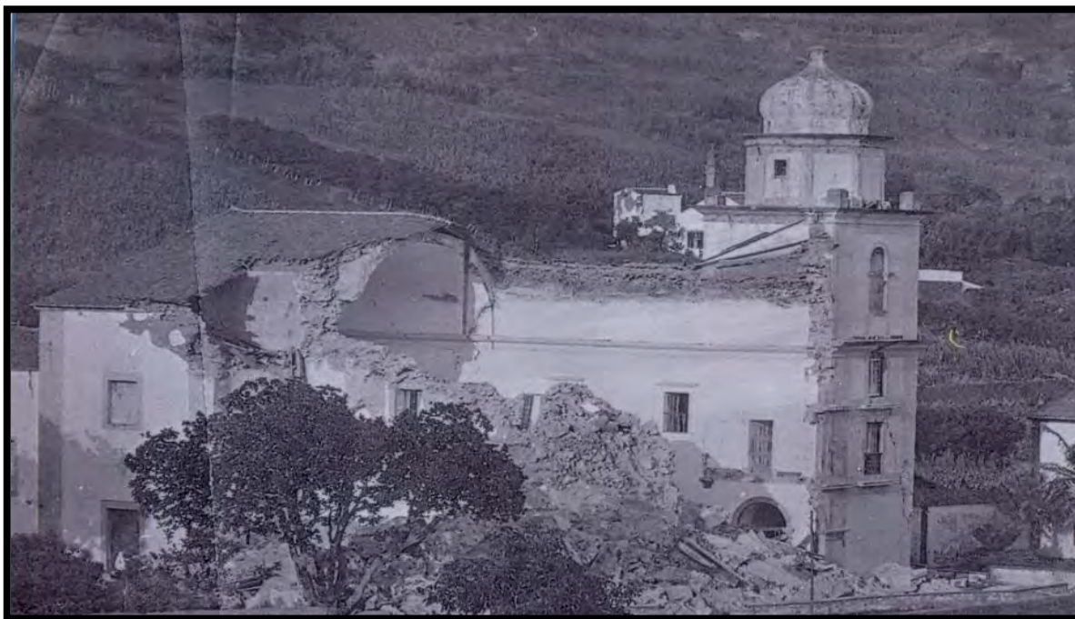
Gravura 7: Igreja da Conceição destruída pelo sismo de 31 de agosto de 1926
