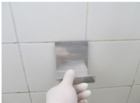
Figura 5. Parede, com o molde de metal 100 cm 2
