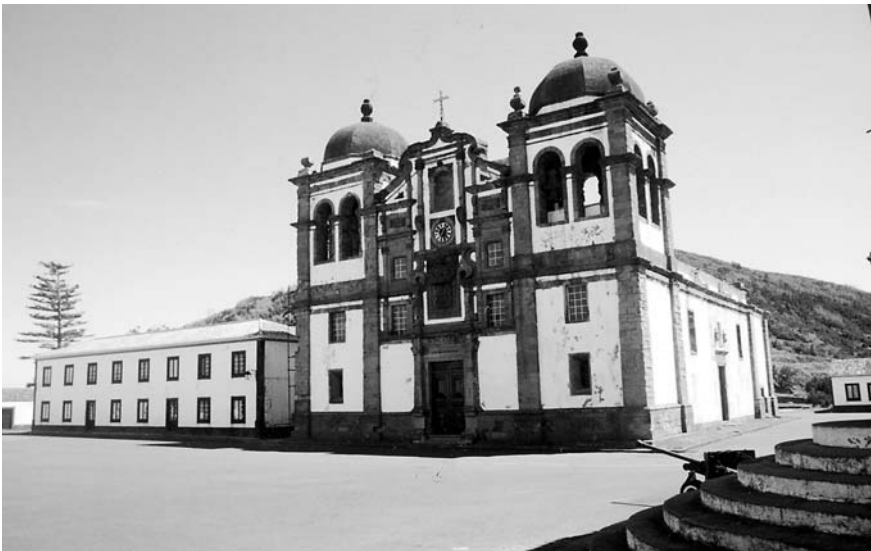
Fig.21 – Ermida de S. João Batista, na praça de armas da fortaleza do Monte Brasil, com o frontispício no eixo do pórtico monumental de acesso.
