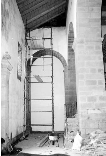
Fig.25 – Aspecto de uma nave lateral, em obras, da ermida de S. João Batista.
