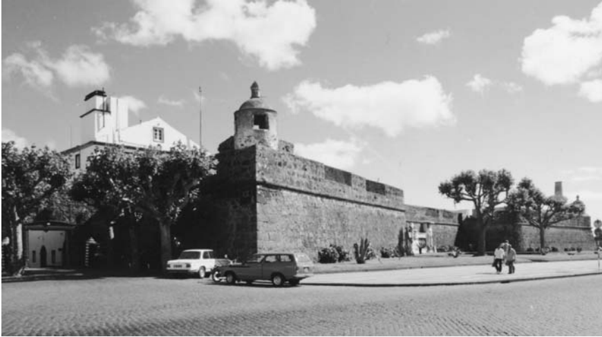
Fig.4 – Ponta Delgada, fortaleza de S. Brás. Vista da cortina virada para norte (terra), com os respectivos baluartes poligonais articulados nas extremidades. Fotografia actual.
