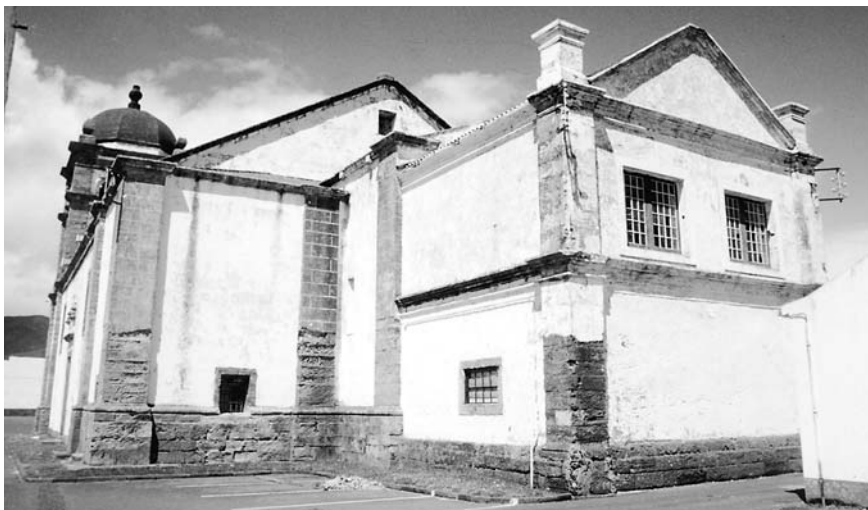
Fig.22 – Ermita de S. João Batista. Aspecto exterior da capela mor, antes das obras de restauro recentes.
