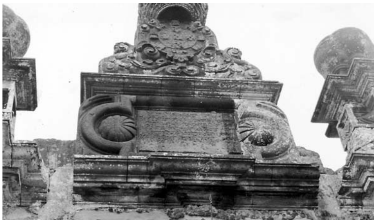
Fig.19 – Pormenor do remate do pórtico principal da fortaleza do Monte Brasil, depois de aplicadas as armas reais do rei João IV.
