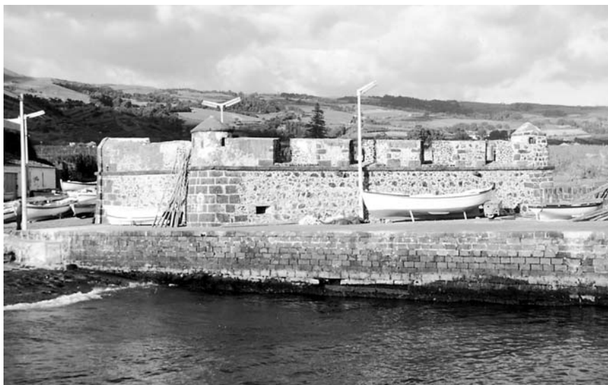
Fig.11 – Vila Franca do Campo (Ilha de S. Miguel), aspecto do arruinado forte do Tagarete, à espera de protecção e recuperação.
