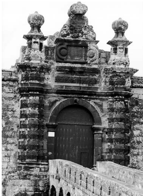
Fig.18 – Pórtico monumental situado a meio da cortina em cujas extremidades se situam os antigos baluartes de S. João e de S. Tiago, com acesso, a partir da esplanada, por ponte de dez arcos de volta perfeita, sobre o fosso agora extinto, de que o último é construção contemporânea no espaço da antiga ponte levadiça.
