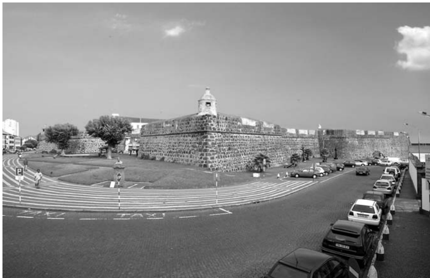
Fig.10 – Ponta Delgada, fortaleza de S. Brás. Vista das cortinas viradas para terra (norte e poente), com guaritas nos baluartes extremos da cortina norte.
