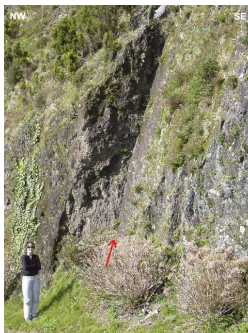
Figura 9.10 – Falha do Cú de Judas exposta no talude da estrada regional em Água Retorta (estação 3). A escala mede 1.6 m.
