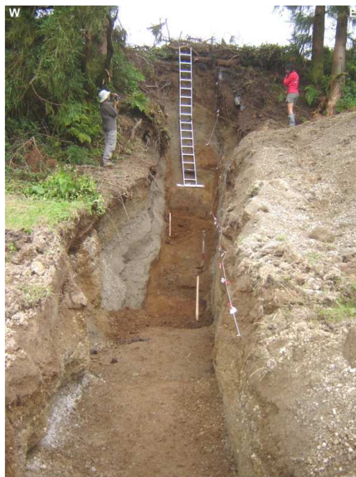
Figura 10.2 – Vista geral da trincheira “Altuprado Sul – TR1” observada de S. A escada tem 4 m.
