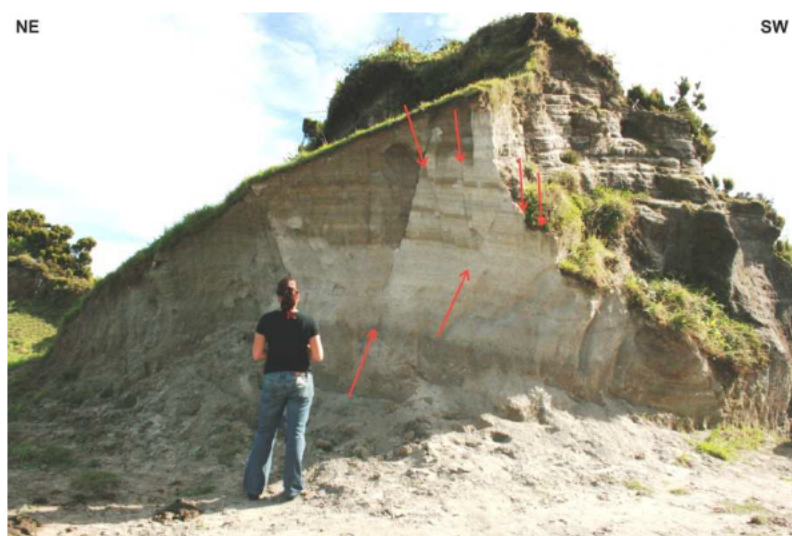
Figura 4.41 – Aspecto geral da estação 132 onde se observam várias falhas a afectar o depósito Sete-P13. A escala mede 1.6 m.
