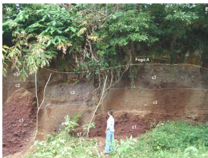
Figura 5.4 – Zona de fractura com cinemática normal observada na estação 76, correspondente ao cone de escórias do Charco do Ferreira. Sobre o depósito do cone (c1 a c3) encontra-se a unidade Fogo A. A escala mede 1.6 m.
