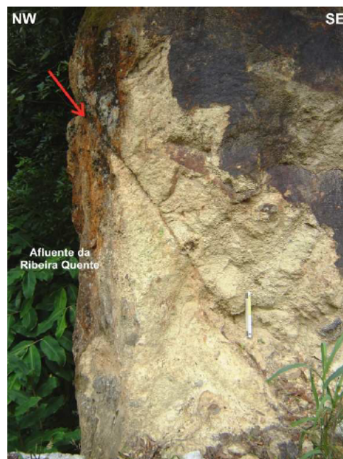
Figura 8.36 – Falha Ribeira Quente 20, observada no talude SE do afluente rectilíneo de direcção N-S da Ribeira Quente (estação 160). A escala mede 22 cm.
