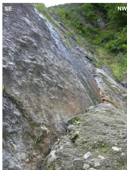
Figura 8.16 – Plano da Falha Ribeira Quente 4, observado na estrada da Ribeira Quente (estação 58 de Carmo, 2004).
