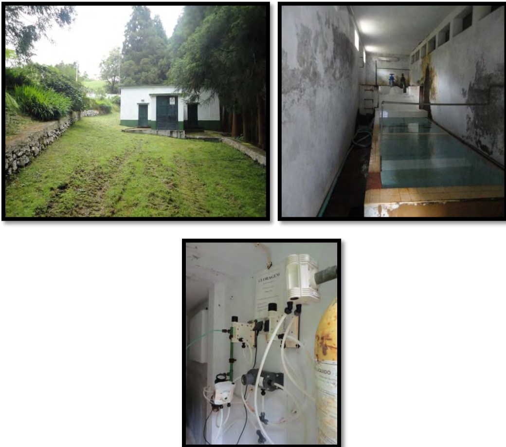
Figura 58 - ETA Nasce Água com tratamento com cloro gás
