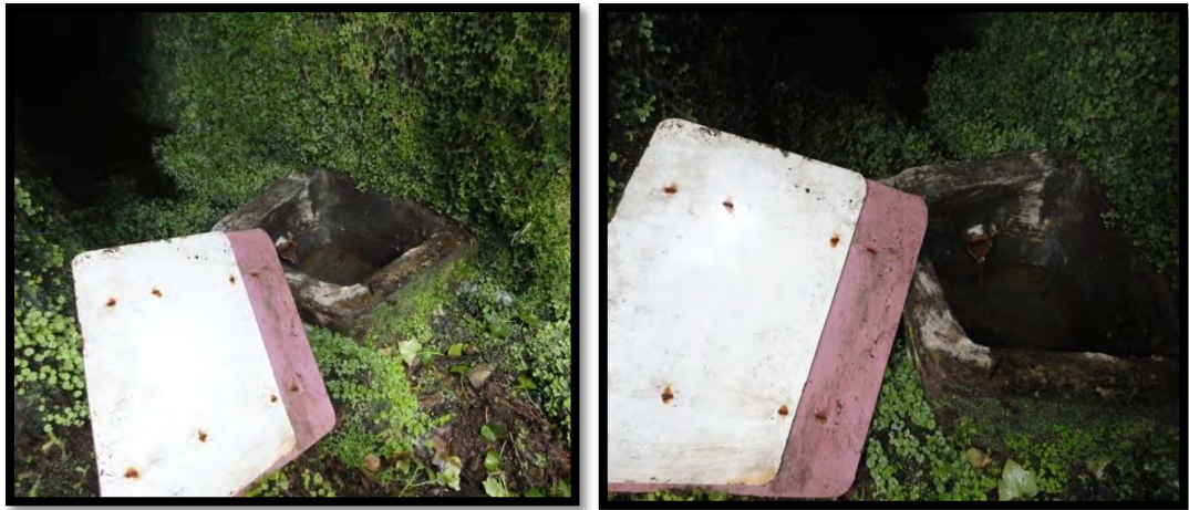
Figura 13 - Captação da nascente Cafuga (sem qualquer proteção) - Altares
