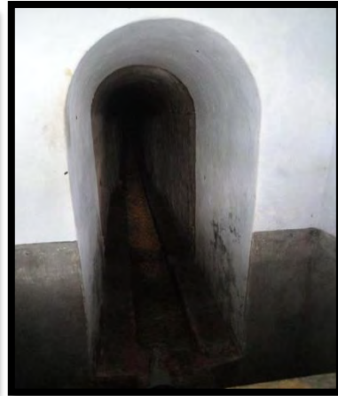
Figura 30 - Captação da nascente Fonte da Telha 4 – Fonte da Telha
