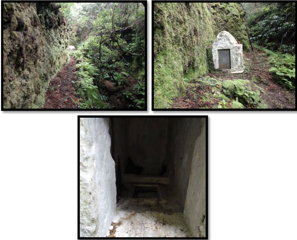
Figura 11 - Captação da nascente Chamuscada de fora (sem proteção imediata) - Altares
