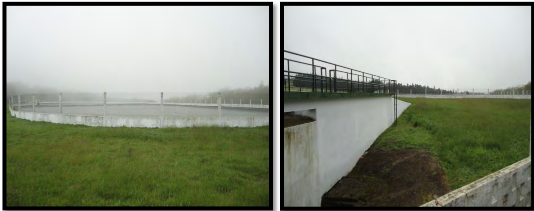
Figura 10 - Captação superficial da Lagoa Altares com tratamento hipoclorito de sódio (NaOCl) - Altares
