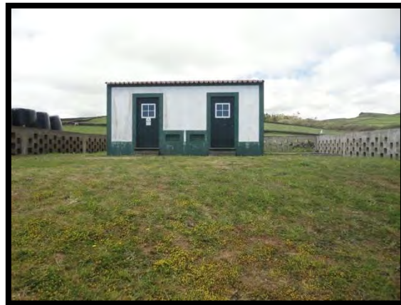
Figura 50 - Captação do Furo Quatro Canadas com tratamento cloro gás – ZA1
