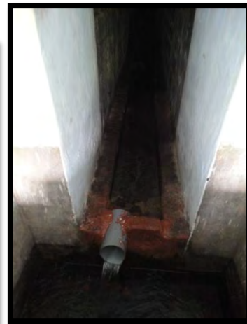
Figura 31 - Captação da nascente Fonte da Telha 5 – Fonte da Telha
