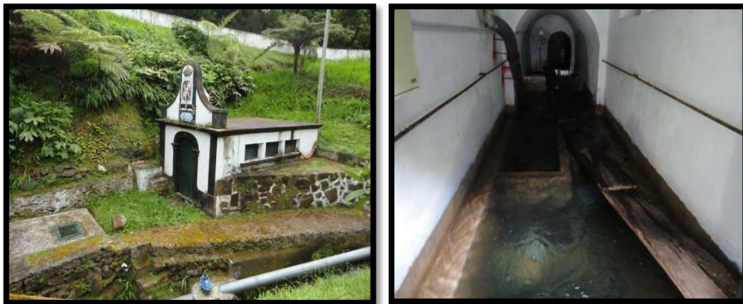
Figura 35 - Captação da nascente Nasce Água Principal – Nasce Água.
