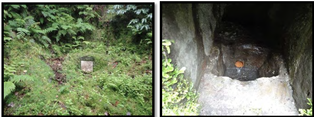
Figura 12 - Captação da nascente Chamuscada de dentro (sem qualquer proteção imediata) - Altares
