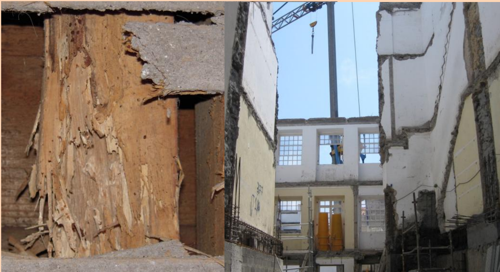
FIGURAS 2 e 3 – Danos causados pela C. brevis numa habitação em Angra do Heroísmo (Guerreiro et. al, 2010)
