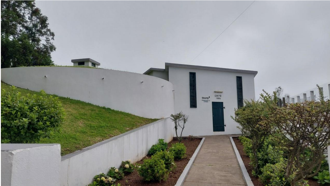
Figura 2.14. Reservatório da Carreira na freguesia de Arrifes (07/05/2023).
