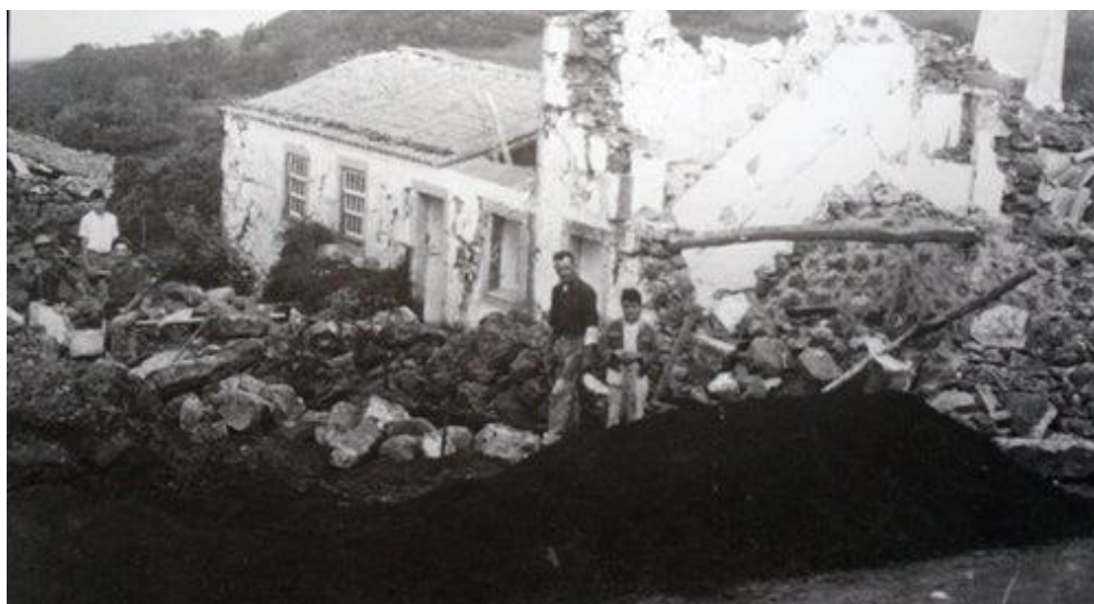
Figura 1.9. Destruição dos edifícios durante a crise sismovulcânica de 1964 na ilha de São Jorge (Fotografia do arquivo da RTP).
