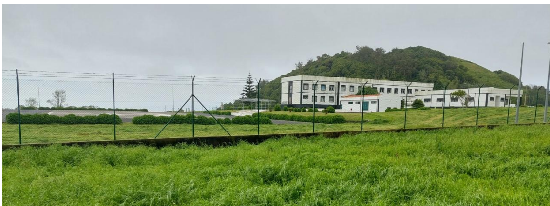
Figura 2.12. Heliporto sediado no COA na freguesia de Arrifes (07/05/2023).
