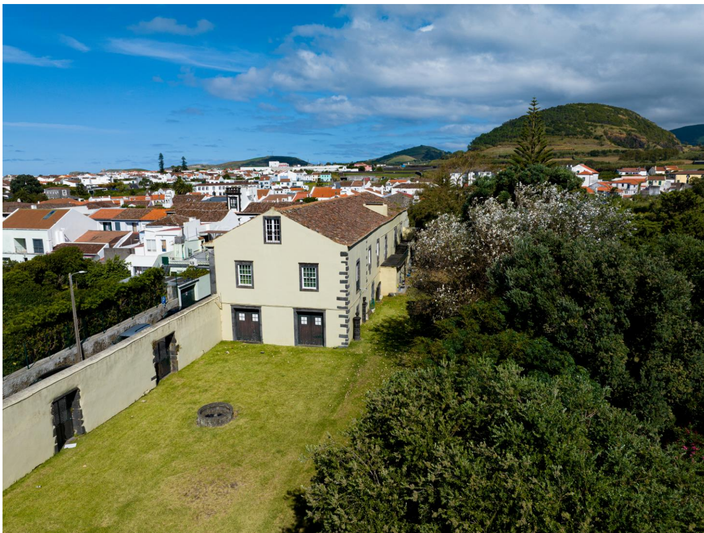
Figura 57b – Vista aérea do Solar de São Vicente Ferreira (ou Ferrer ), sede do Museu Municipal da Ribeira Grande. Fonte: Luís Furtado – CMRG, 2023.
