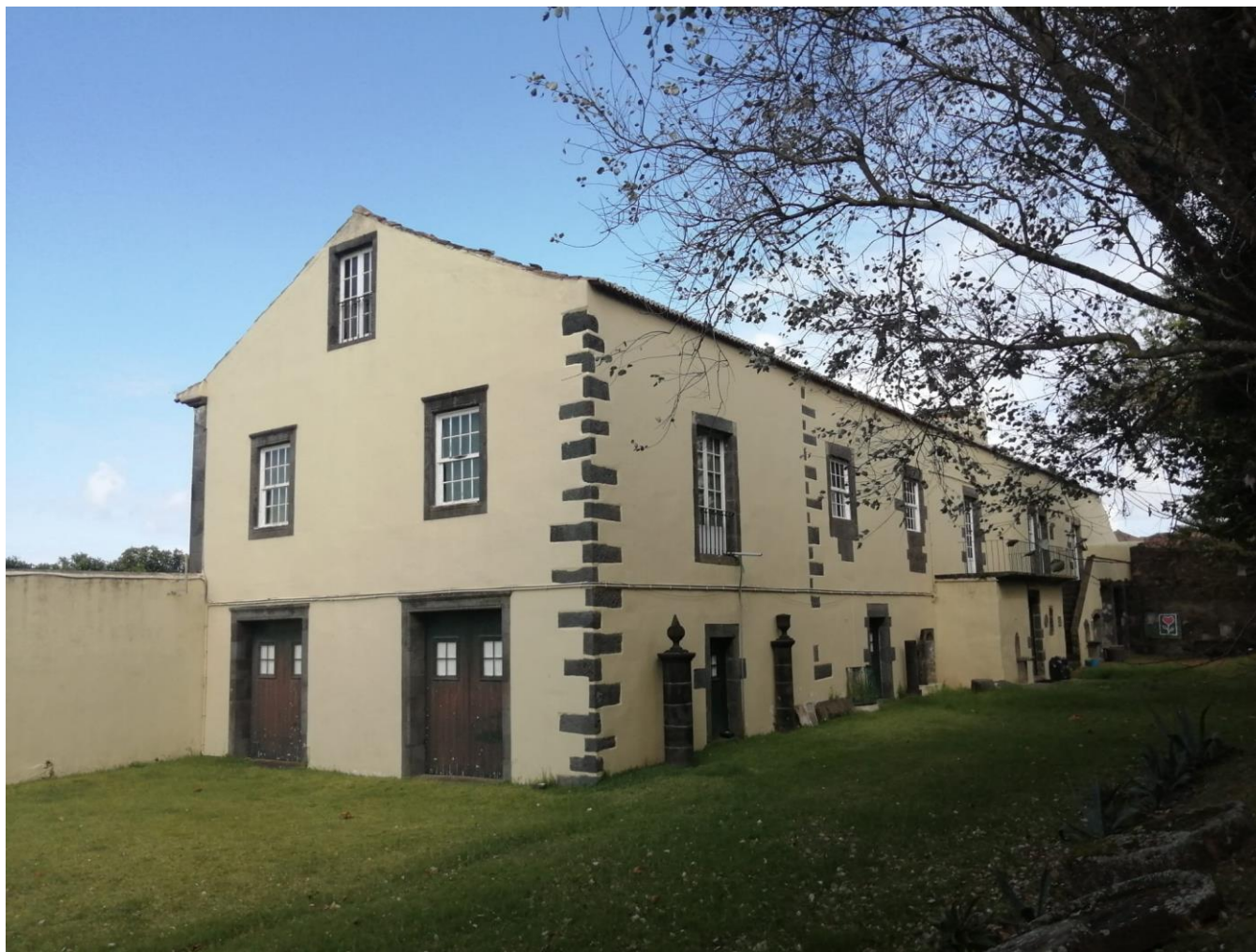
Figura 38 – Fachadas tardez e lateral do Solar de São Vicente Ferreira (ou Ferrer ), sede do Museu Municipal da Ribeira Grande. Fonte: Rogério Medeiros, 2023.
