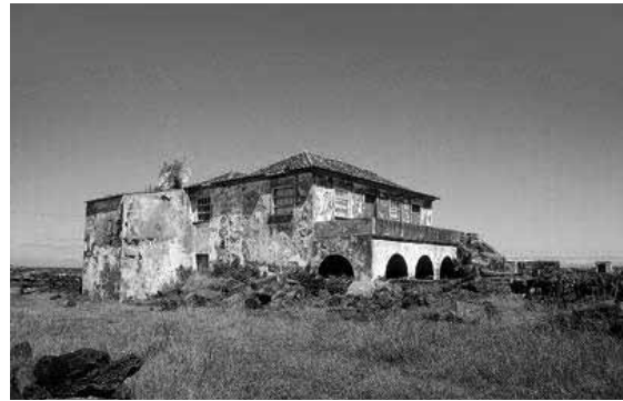
Fig.2 - Casa do Castelhana. Foto IPI-IAC
