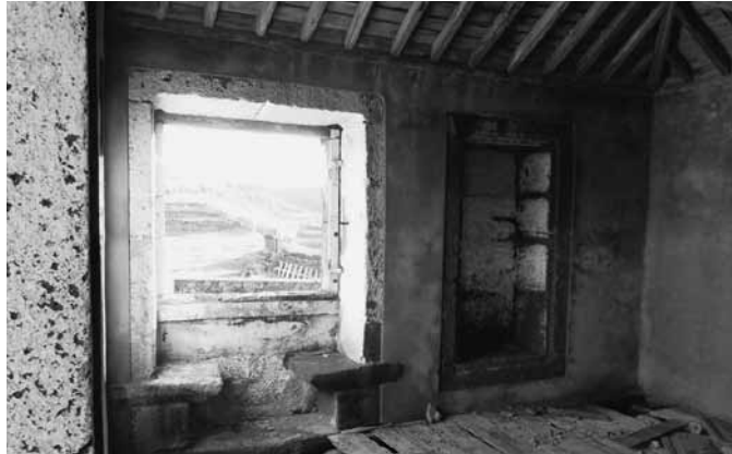
fig.10 - Janela de assento com moldura de arestas redondas e «bico» do arco em carena. Foto Isabel Albergaria.
