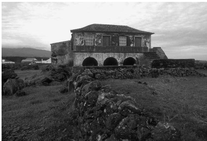
Fig.5 - Casa do Castelhana, vista de nascente. Foto IPI-IAC
