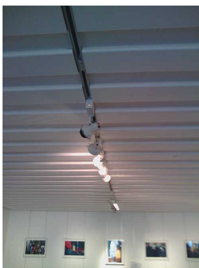
Gravura 10 – Trilho de iluminação que corre ao centro em ambas as salas
