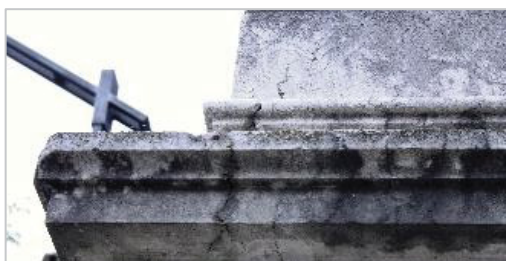
Figura 56 - Fissuração da base do busto erguido a Roberto Ivens (Foto da autora).
