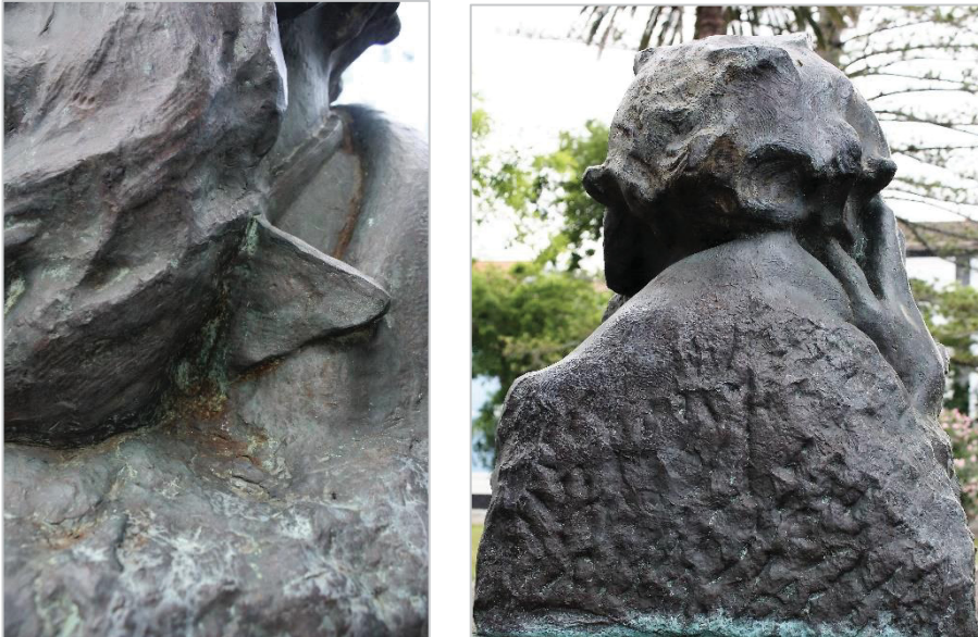
Figura 64 - Pormenor de manchas de corrosão sobre a superfície de um dos lados do busto a Antero de Quental, na Av. dos Mártires (Foto da autora).
