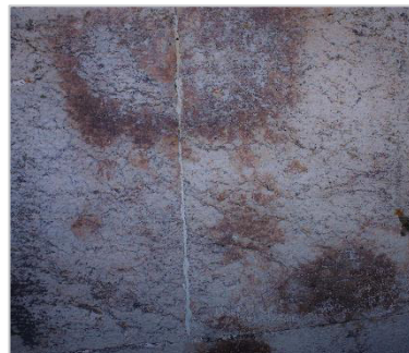
Figura 48- Pormenor de manchas rosa que se desenvolveram no monumento erguido aos mortos da grande guerra (Foto da autora).
