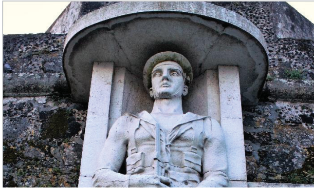
Figura 50 - Pormenor que documenta uma mancha de humidade acima da representação da cabeça de um dos soldados que integram o monumento erguido aos mortos da grande guerra. Ambas as figuras do monumento apresentam este tipo de mancha em local idêntico (Foto da autora).
