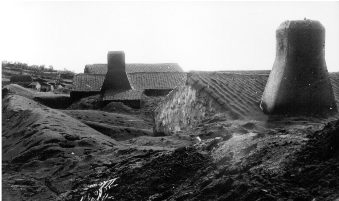
Foto 6.2 – Casas sujeitas a acumulações de mais de 2 m de espessura de cinzas e cujos telhados não desabaram por terem sido alvo de operações de limpeza regulares (Fotografia gentilmente cedida por Foto Jovial).
