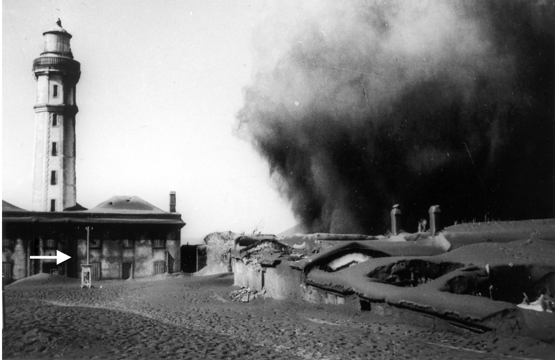
Foto 6.1 – Aspecto do Farol do Capelo e de alguns edifícios vizinhos, durante uma fase surtseiana da erupção dos Capelinhos, onde se distinguem diversos telhados colapsados sob o peso das cinzas húmidas, enquanto se mantêm preservadas algumas delicadas estruturas verticais como um poste eléctrico ou as chaminés dos edifícios. Este local situa-se a aproximadamente 500 m da cratera (Fotografia gentilmente cedida por Foto Jovial).
